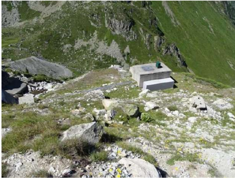
Figure 69 : Vue du puit de L'Oueil Nègre
