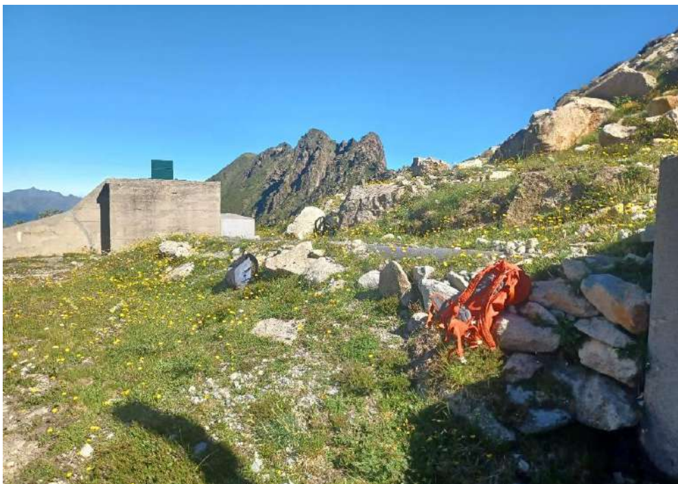
Figure 21 : Puits d'Oueil Nègre
