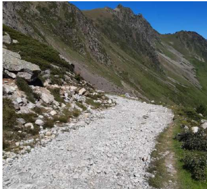
Figure 121 : Piste existante pour accéder la base vie de la Glaire inférieure
