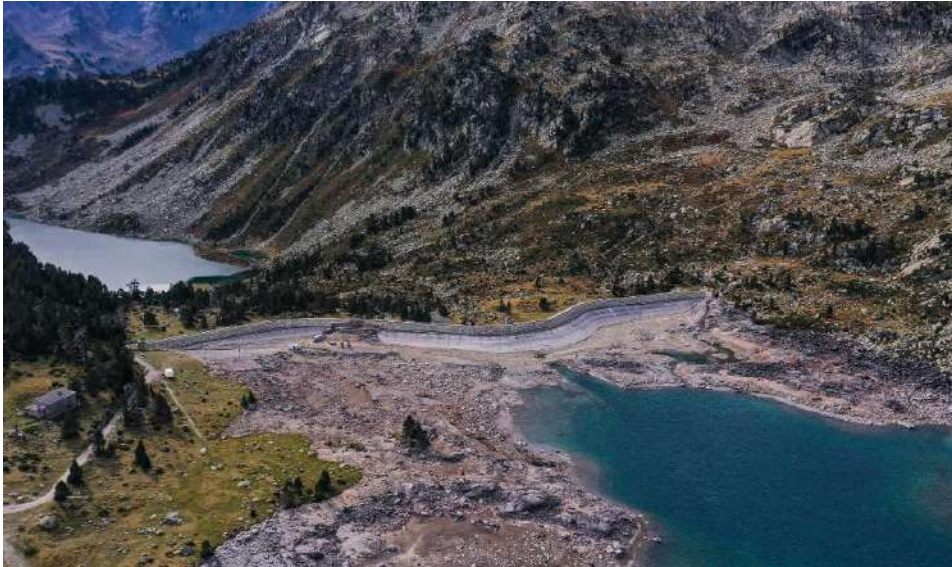
Figure 16 : Retenue d'Aubert abaissée en 2014 via l'utilisation de la vanne de fond du barrage
