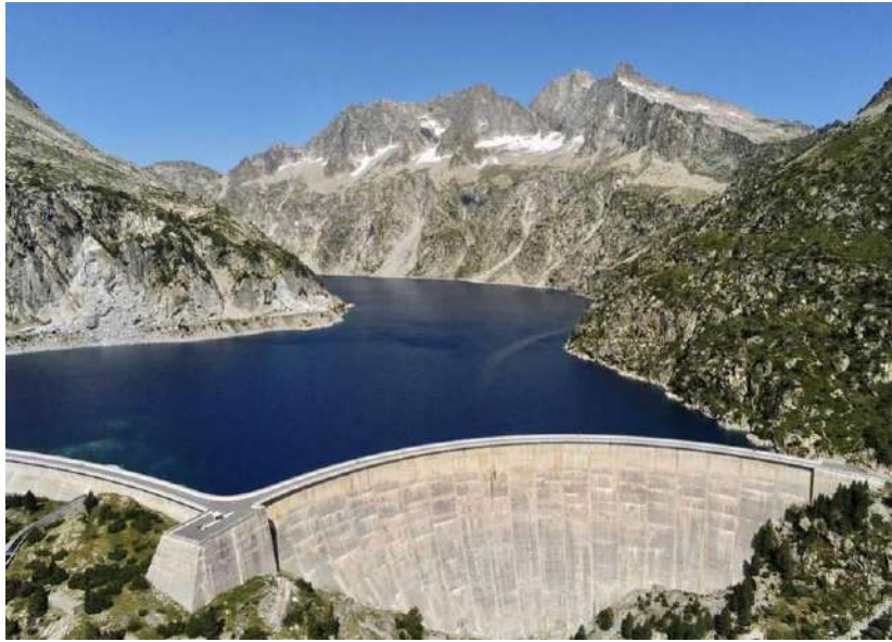
Figure 13 : Barrage de Cap de Long
