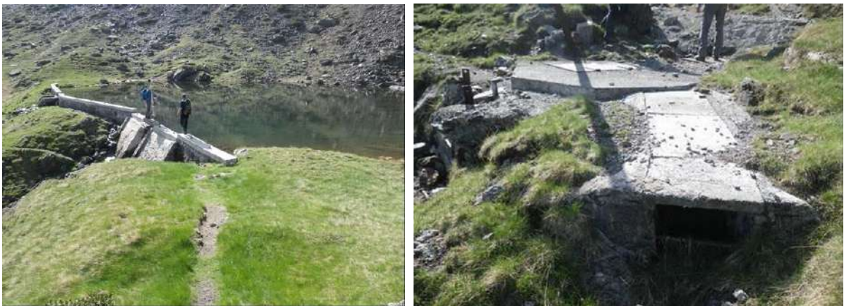
Figure 28 : Prise d'eau du Laquet de Maucapéra et Avant-Puits
