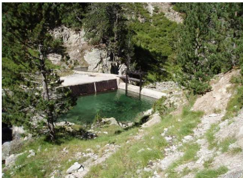
Figure 17 : Prise d'eau d'Aygues Cluses
