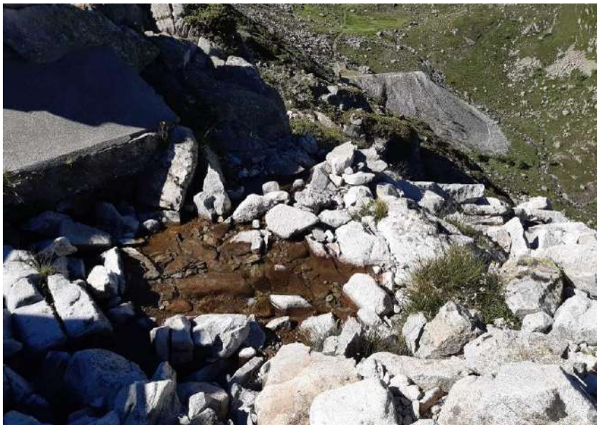
Figure 33 : Aval de la prise d'eau d'Oueil Nègre
