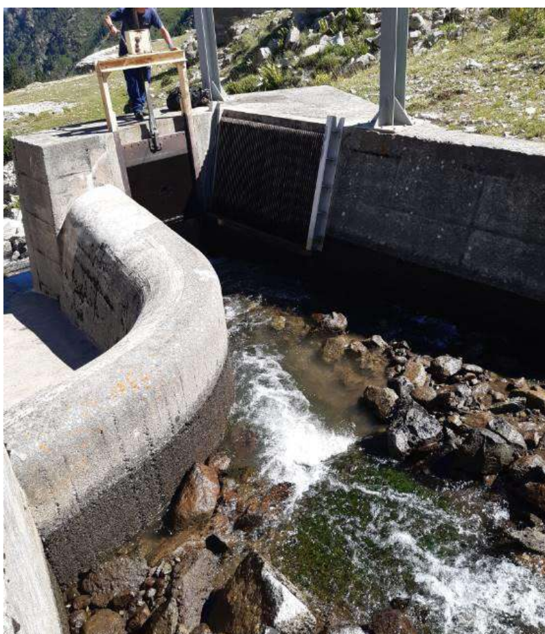
Figure 23 : Prise d'eau de la Glaire inférieure
