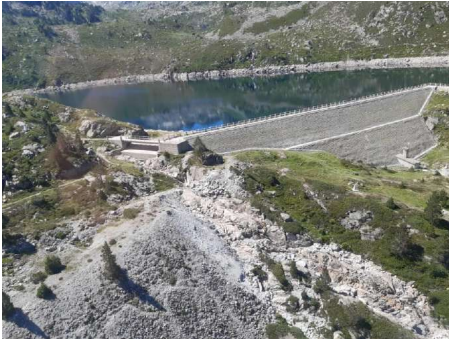
Figure 41 : Barrage d'Escoubous et son déversoir en RD
