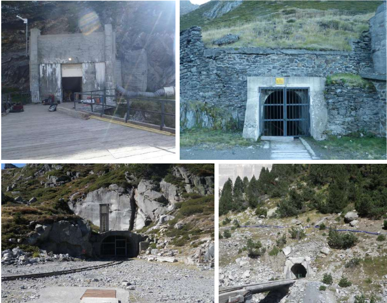
Figure 122 : Présentation des fenêtres d'accès à la galerie utilisées pendant les travaux
