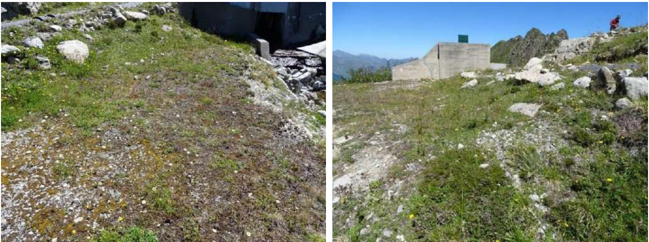
Figure 70 : Pelouse rocailleuse sur plateforme de remblai et entre la prise d'eau et le puits
