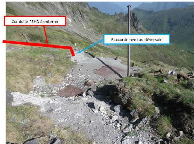
Figure 96 : Implantation de la conduite PEHD enterrée
