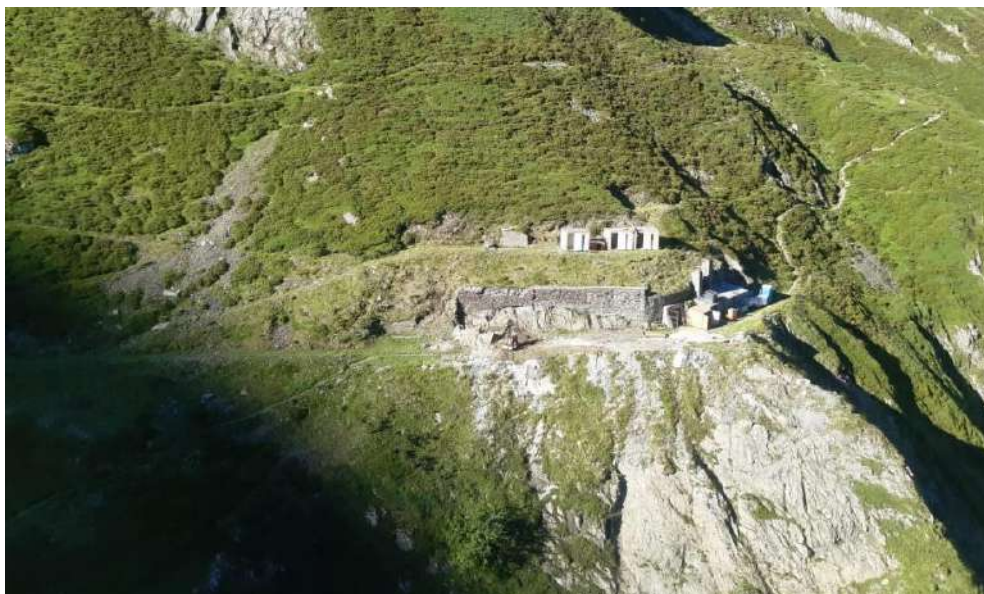
Figure 105 : Travaux en cours au niveau de la Fenêtre de Maucapéra le 13 juillet 2022
