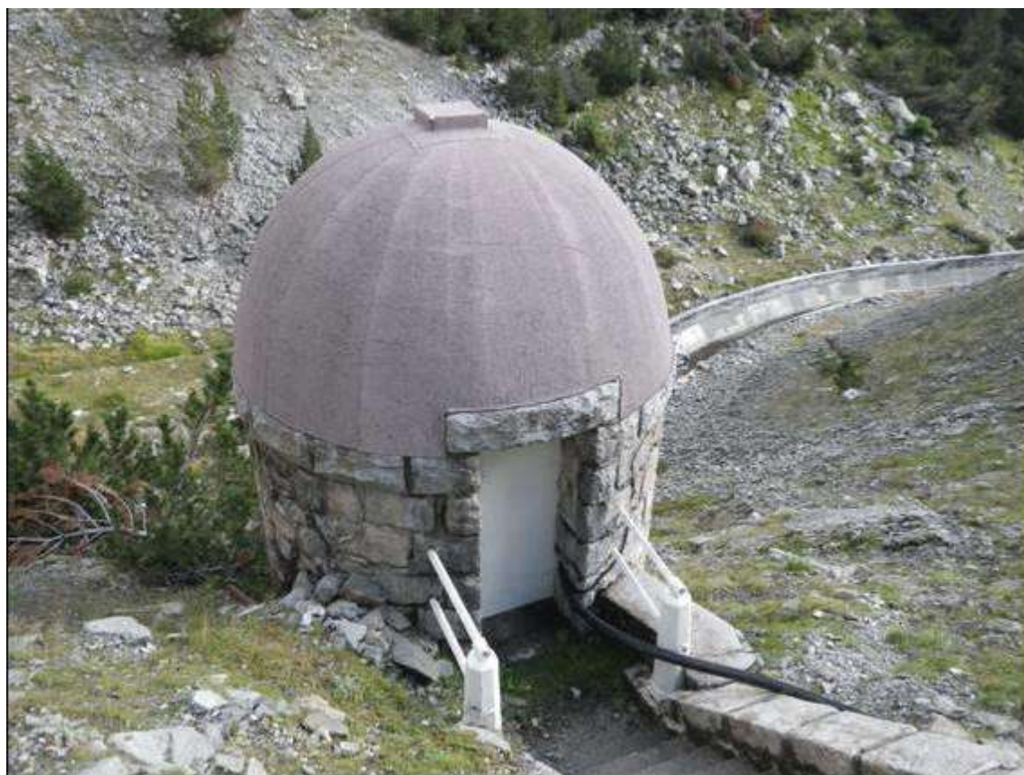
Figure 102 : Accès aux vidanges de fond – Maçonnerie de la tour à réparer
