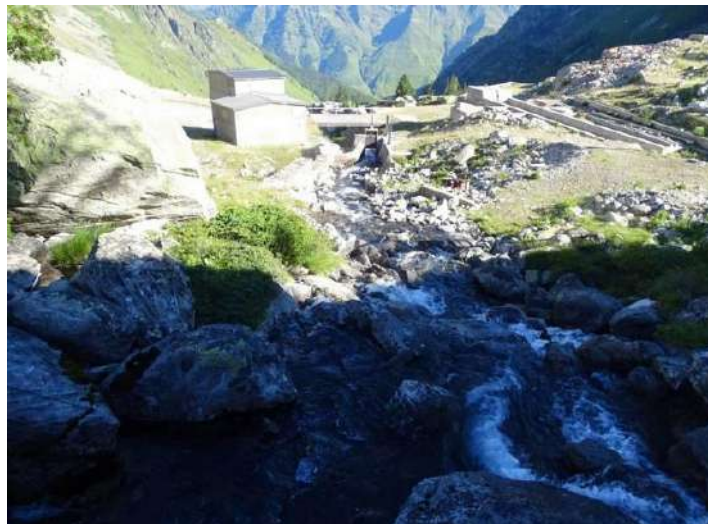
Figure 127 : Zone de contact avec un Calotriton et vue d'ensemble de la PE de la Glère inférieure
