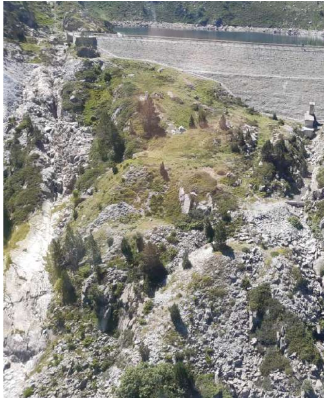
Figure 44 : Zoom sur le déversoir d'Escoubous en RD
