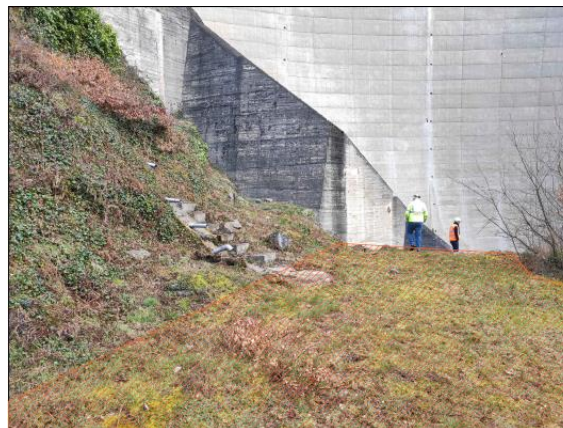
Figure 14 : Vue sur la rive droite, entre le barrage et l'usine, régulièrement entretenue (source : EDF)
