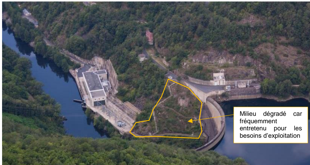
Figure 13 : Vue aérienne du barrage et de l'usine de Couesque (source : survoldefrance.fr)
