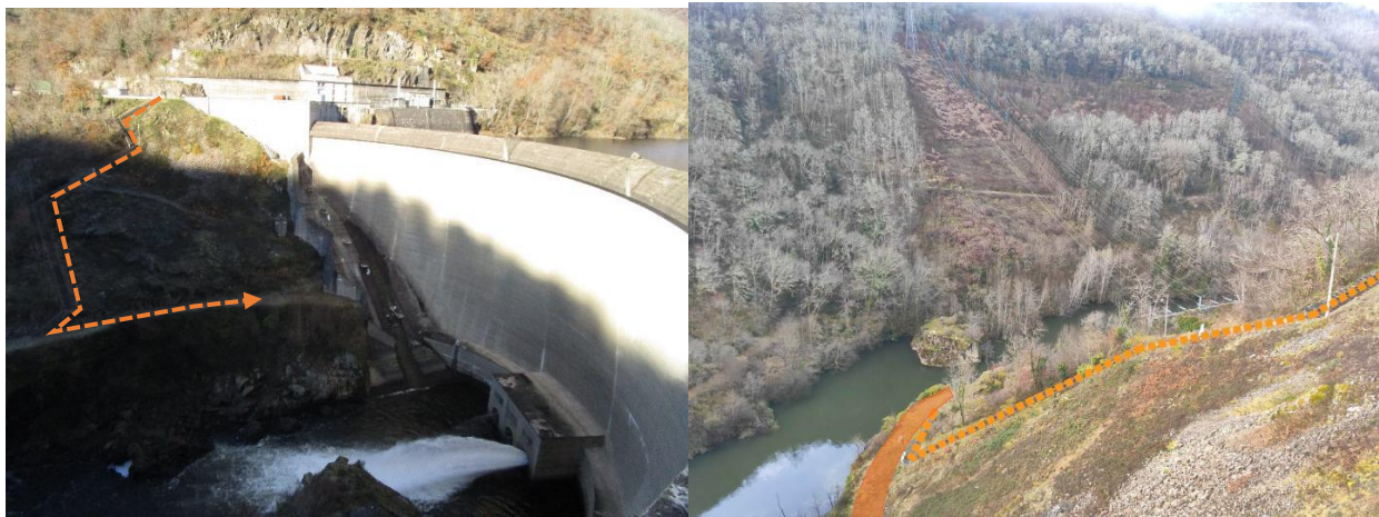
Figure 29 : Vues sur la rive droite (en orange accès via l'escalier existant) (source : EDF)
