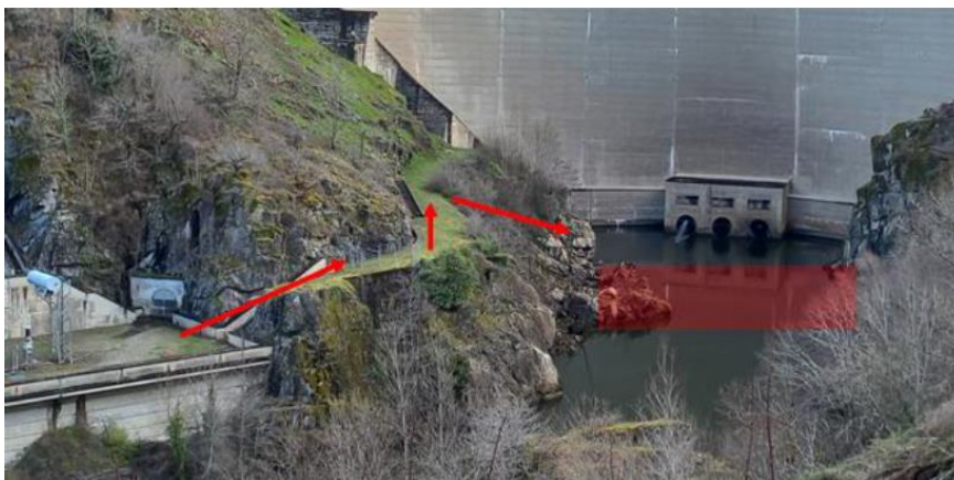
Figure 26 : Photo de l'accès à aménager de l'emplacement de la variante du batardeau (source : EDF)
