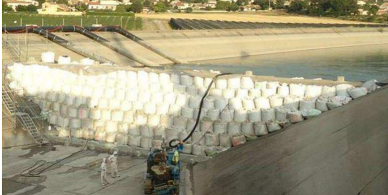
Figure 35 : Exemple de batardeau en big bag (canal EDF d'Oraison) (source : EDF)
