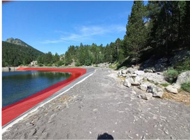
Figure 31 : Zone de travaux sur le parement bétonné en dehors de zones à enjeux
