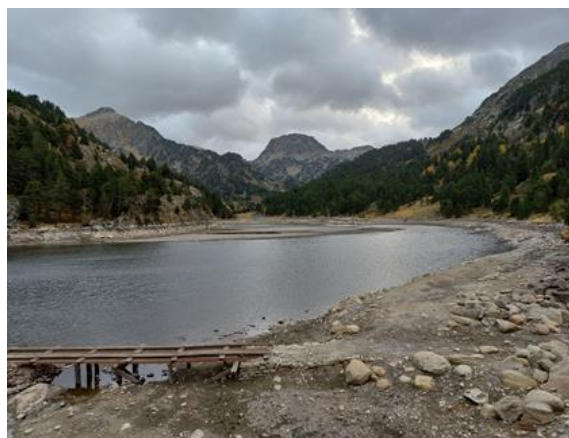
Figure 29 : Volume résiduel dans la retenue après abaissement
