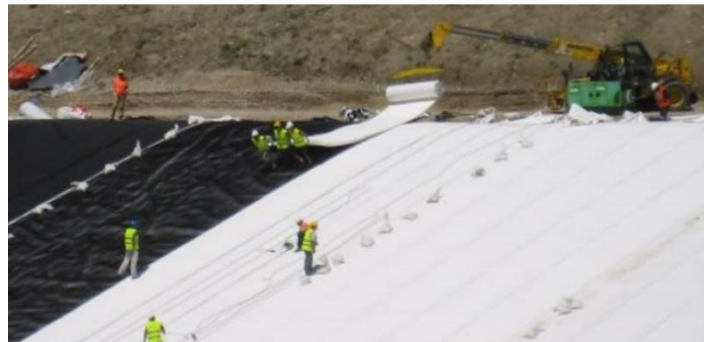
Figure 5 : Exemple de mise en place d'une géomembrane non adhérente et drainée
