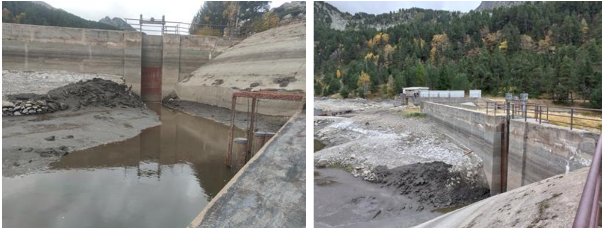
Figure 28 : Absence d'accumulation de matières fines au droit de la vanne de fond et Banquettes sédimentaires avec une pente faible (Source : EDF, abaissement 2022)
