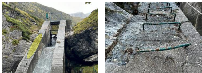
Figure 22 : Echelons à remplacer sur le bajoyer (source Getec)
