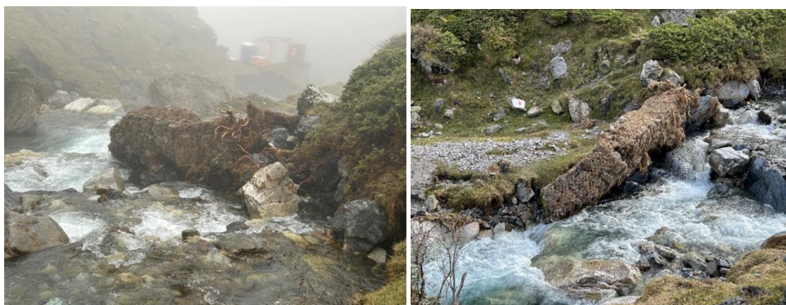
Figure 15 : Mur en gabions détruit par la crue (vue depuis l'amont et depuis la RG)
