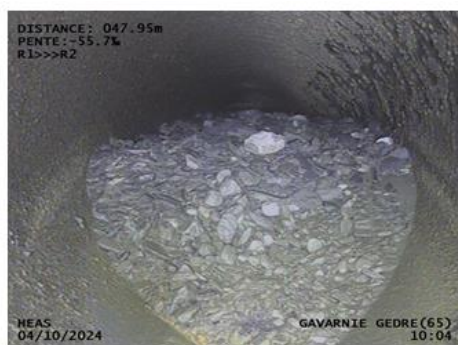
Figure 42 : Vue du siphon engravé lors de l'expertise post crue
