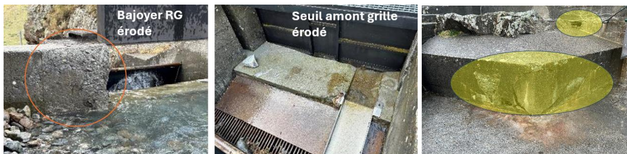
Figure 31 : Erosion des bétons
