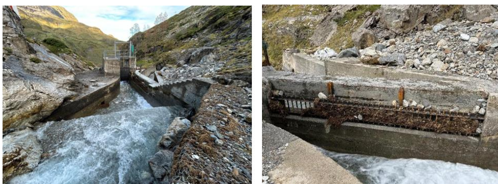
Figure 14 : Vue de l'entonnement depuis l'amont / Passerelle et grille d'entonnement (source Getec)
