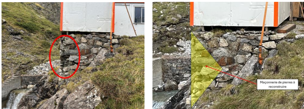
Figure 18 : Mur de soutènement dégradé et localisation de la zone à reprendre (source Getec)
