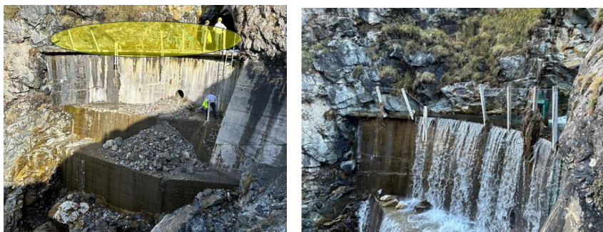
Figure 23 : Garde-corps à remplacer
