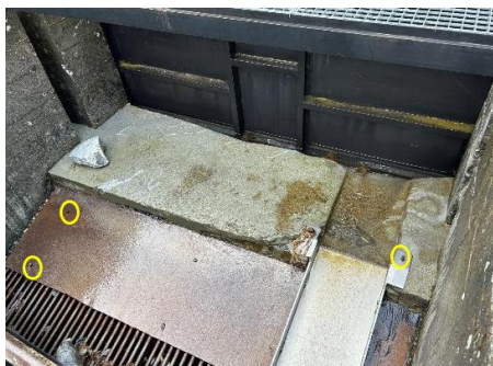
Figure 32 : Localisation des fixations à reprendre (source Getec)
