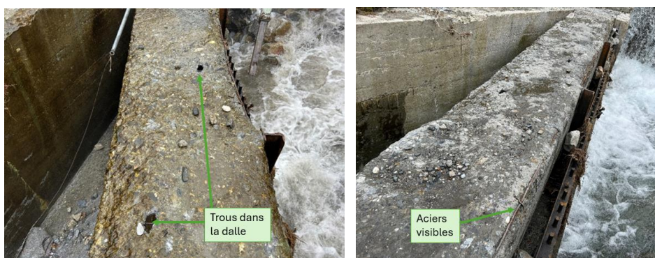
Figure 19 : Dégradations constatées sur le béton de la passerelle des grilles
