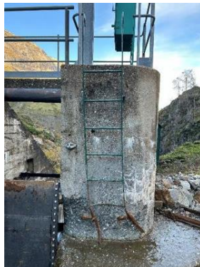
Figure 21 : Echelle d'accès dégradée par la crue
