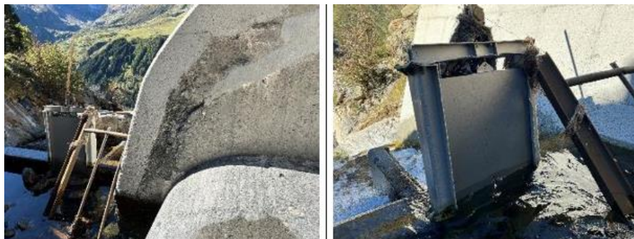
Figure 38 : Parement amont de la voute dégradé par les impacts de blocs rocheux / Vanne de chasse hors service
