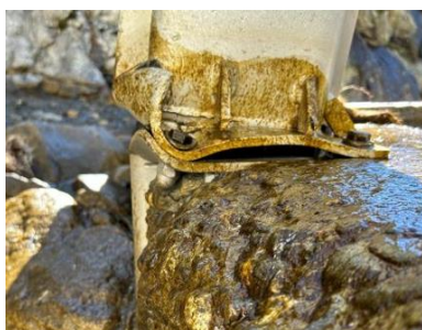
Figure 37 : Platine d'assemblage RD et caillebotis à remplacer (source GETEC)
