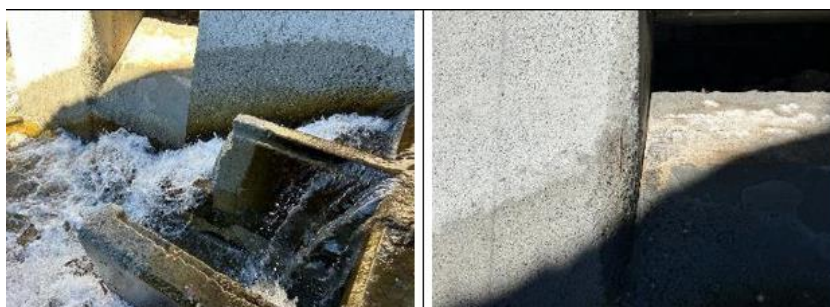
Figure 39 : Génie civil du pertuis dégradé en RD / Aciers visibles à l'aval du déversoir de la voute (érosion du béton)
