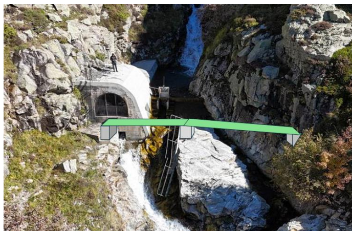
Figure 36 : Passerelle détruite lors de la crue & Schéma de principe de la future passerelle (Source Getec)
