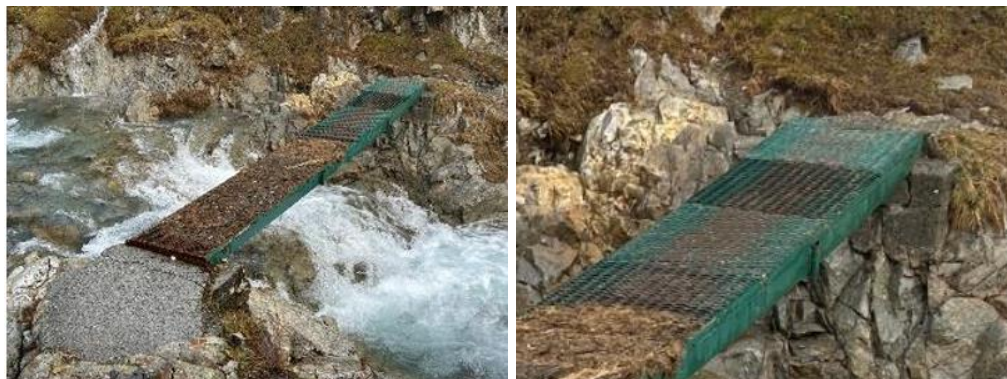
Figure 30 : Passerelle déformée et sans garde-corps – Culée rive gauche fissurée et fragilisée (source Getec)
