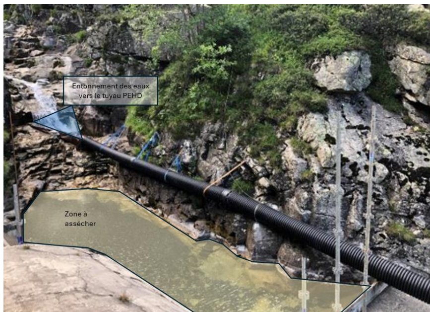
Figure 11 : Chantier de 2021 : dérivation provisoire (à gauche) (source Getec)
