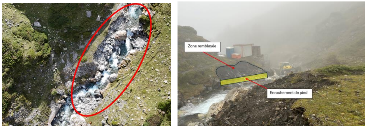
Figure 17 : Berges érodées par la crue à consolider – schéma de principe du confortement (source Getec)
