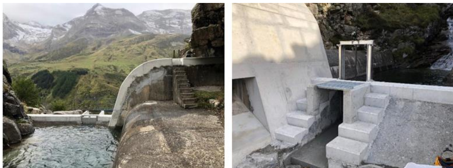
Figure 34 : Déversoir avec vanne de chasse avant la crue (novembre 2021)(vue depuis l'amont -à gauche- et depuis l'aval -à droite)
