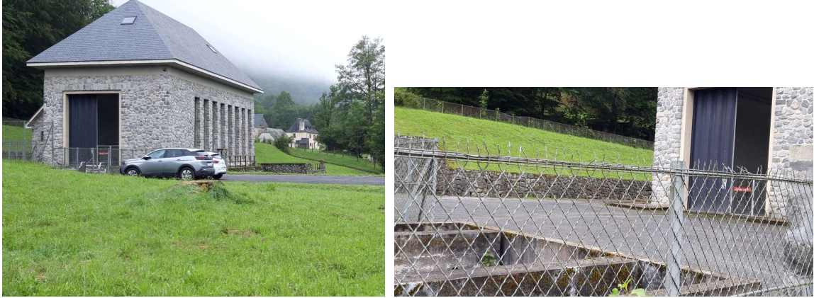
Figure 19 : Vue de l'environnement au droit de l'usine d'Aucun
