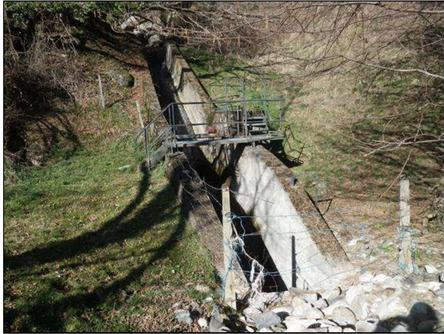
Figure 10 : Vue aval de la PE
