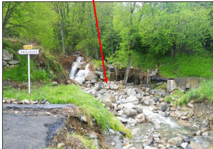
Figure 14 : Vue du site peu de temps après la crue
