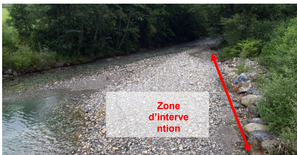
Figure 43 : Vue de la berge où auront lieu les travaux en aval du barrage de Terre-Nère
