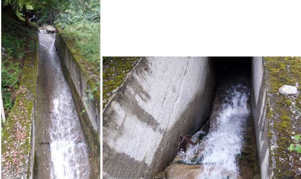
Figure 41 : Vue en amont de la PE (à gauche) et en aval juste avant le passage en souterrain (à droite)
