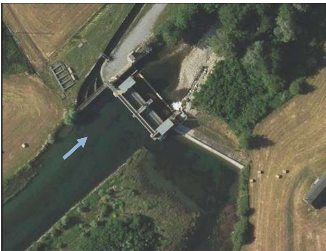
Figure 5 : Vue aérienne du barrage de Terre-Nère
