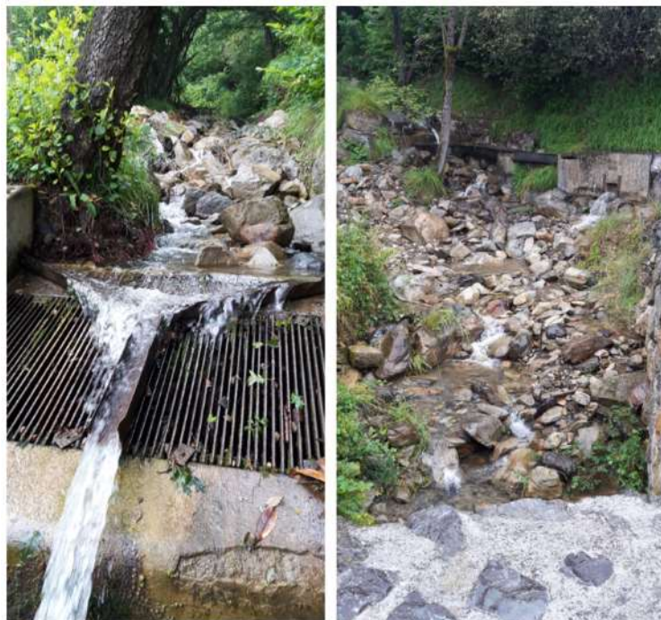
Figure 40 : Vue du ruisseau de Lasparès en amont et en aval de la PE de Gaillagos
