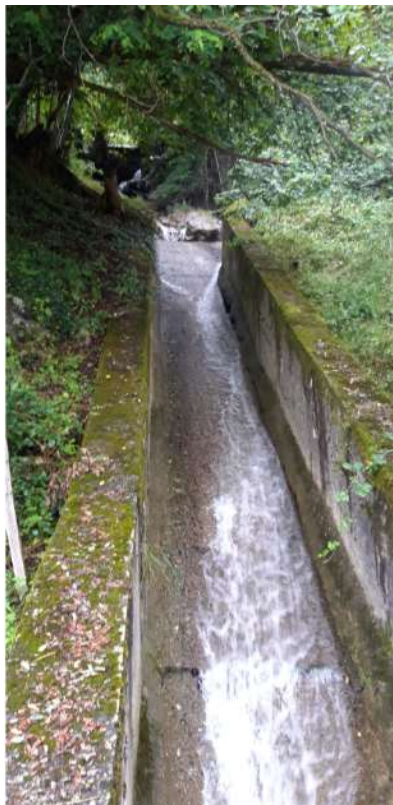
Figure 54 : Vue de l'environnement autour de la prise d'eau
