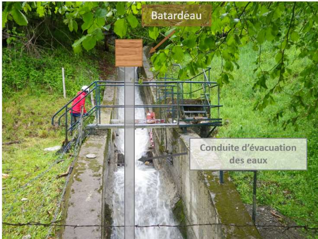
Figure 30 : Schéma de l'isolement hydraulique à la PE de Domec
