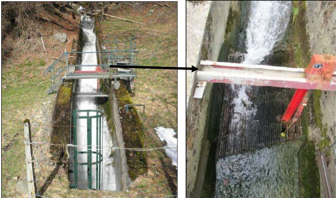
Figure 8 : Vues sur les grilles de prise (avant la crue de 2018)
