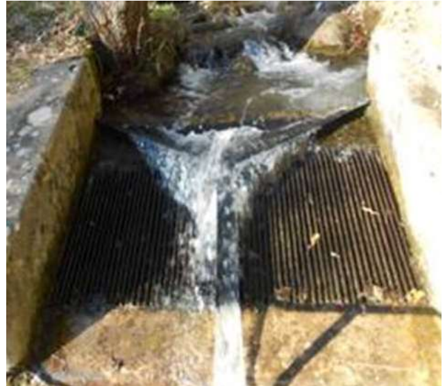
Figure 12 : A gauche : vue aval de la PE (avant la crue de 2018) – A droite : vue du dispositif de restitution du débit réservé (avant la crue de 2018)
