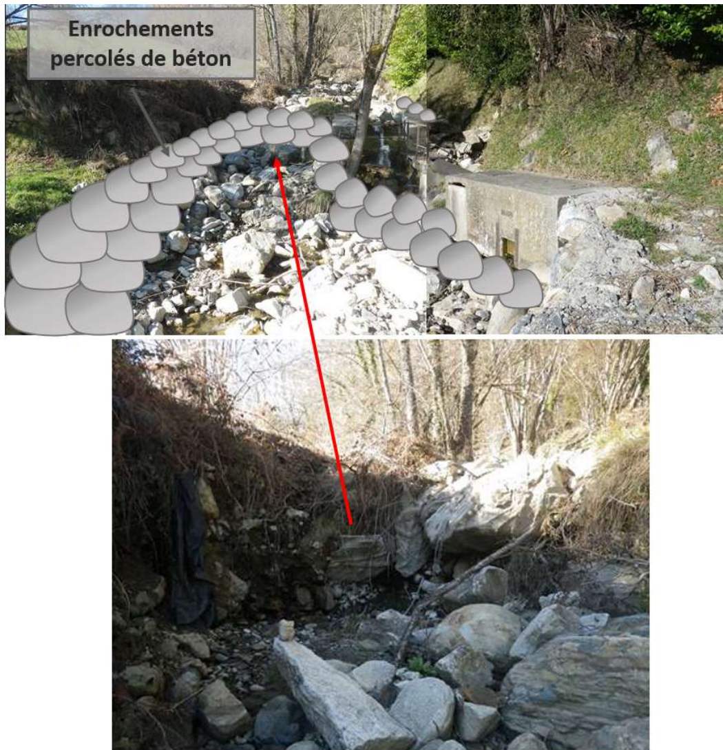
Figure 25 : Schéma des enrochements percolés à mettre en œuvre
