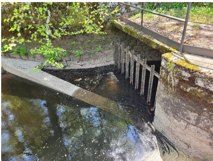
Figure 40 : Photo du mur dessableur en entrée de conduit Bédaule → Bès
