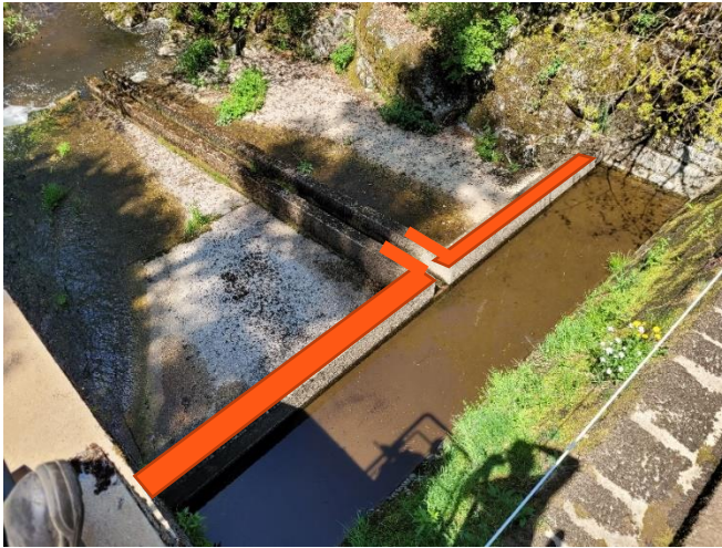
Figure 45 : Rehausse du mur de réception de la dévalaison et de l'amont de la goulotte
