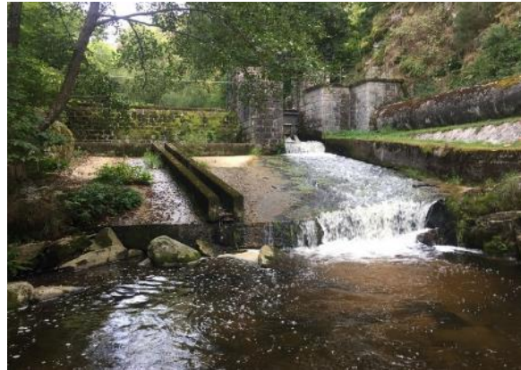
Figure 8: Vue d'aval du barrage
