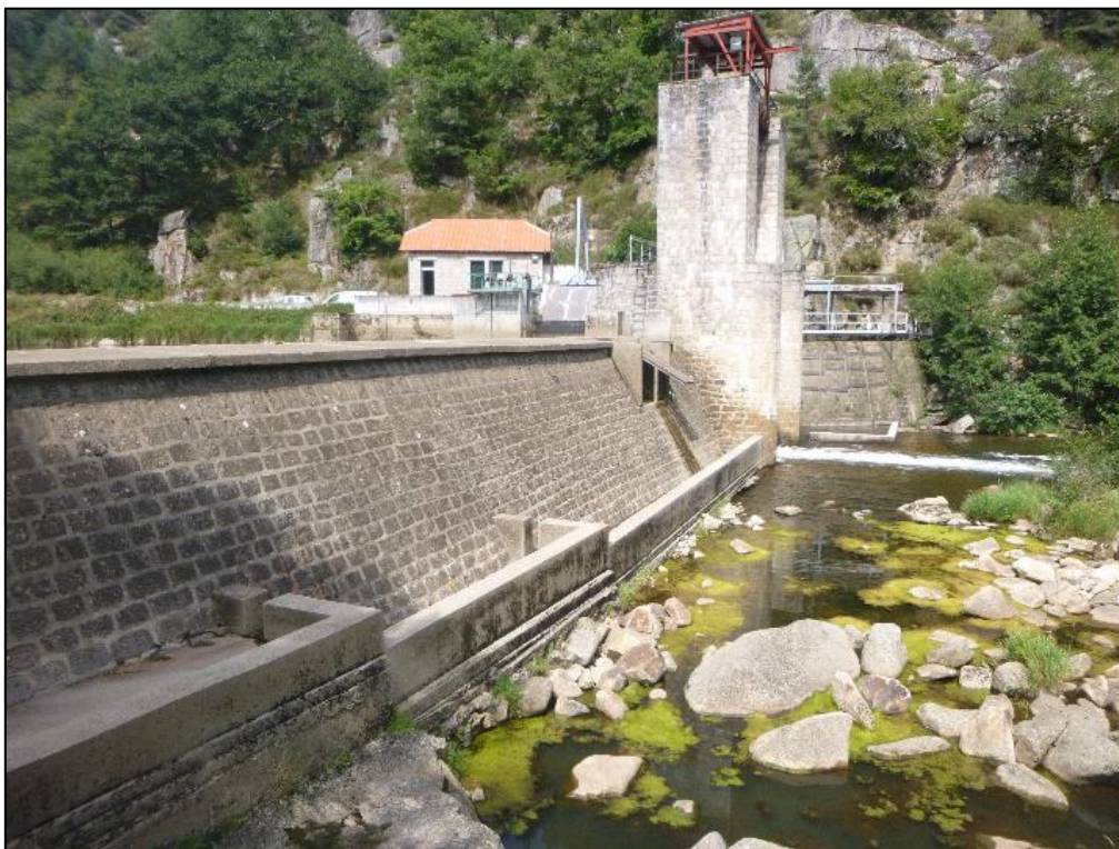
Figure 5: Vue du barrage depuis l'aval rive droite
