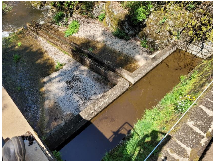
Figure 43 : Bassin de dévalaison
