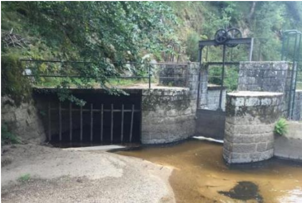
Figure 7: Vue du départ de la conduite de dérivation et de la vanne de vidange en rive gauche du barrage
