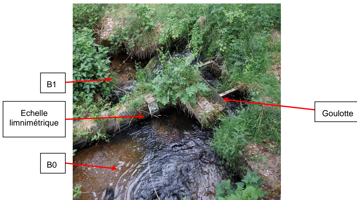
Figure 50 : Photo de la partie amont de la passe à poissons
