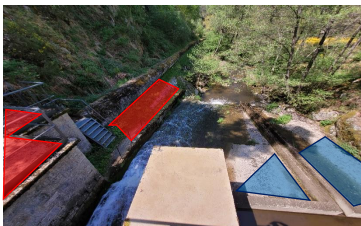
Figure 64: Stockage du matériel Bédaule
