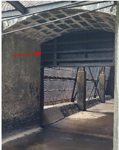
Figure 10 : Photo de la vanne vue depuis l'aval
