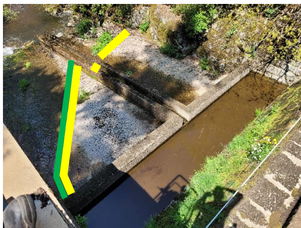
Figure 60 : Bédaule - Disposition du batardeau du bassin
