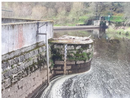
Figure 35 : Echelle limnimétrique actuelle de niveau de retenue
