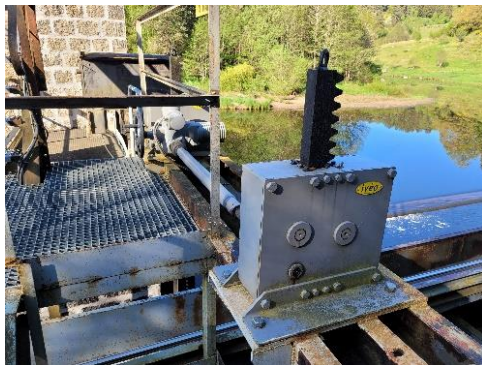
Figure 11 : Système de motorisation de la vanne
