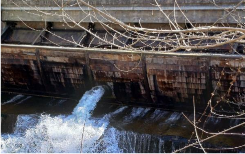
Figure 6: Conduite actuelle de délivrance du débit délivré à l'aval à obstruer
