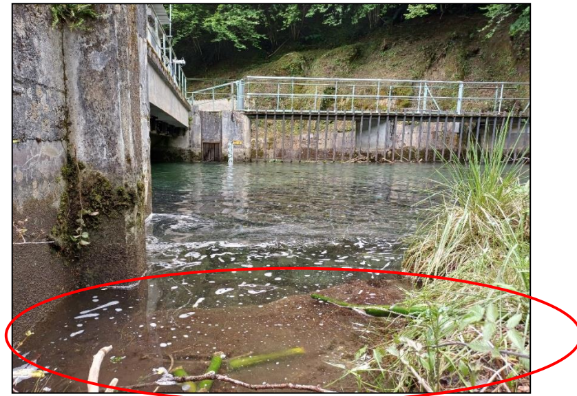
Figure 16 : Vue des blocs à enlever
