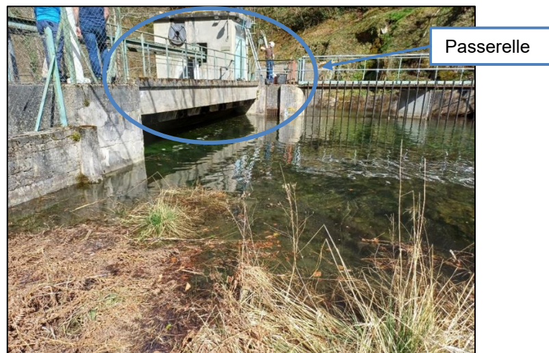
Figure 5: Vue amont de la prise d'eau
