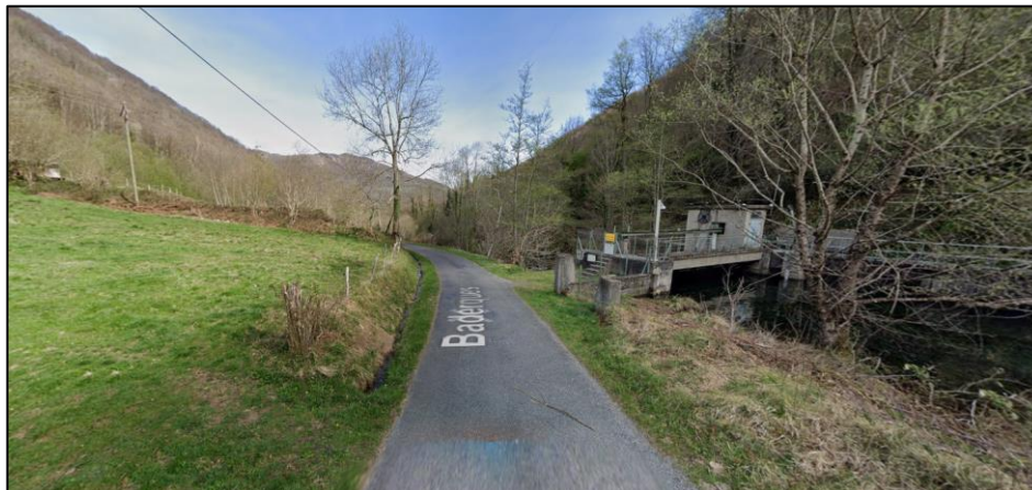
Figure 10: Vue de la voie d'accès
