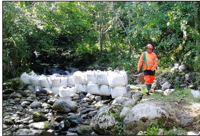
Figure 12 : Exemple de batardeau en big bag
