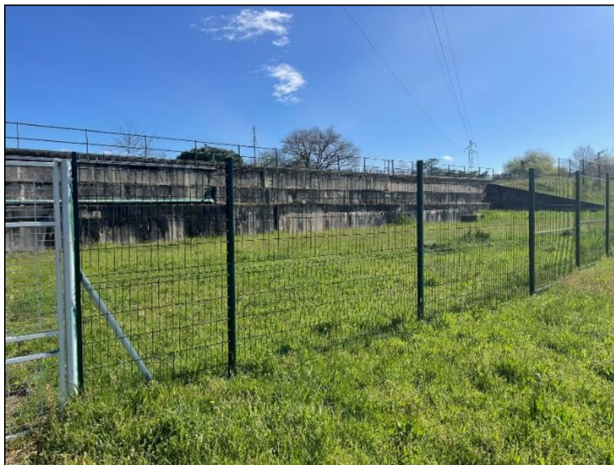
Figure 21 : Vue de la zone d'installation de chantier
