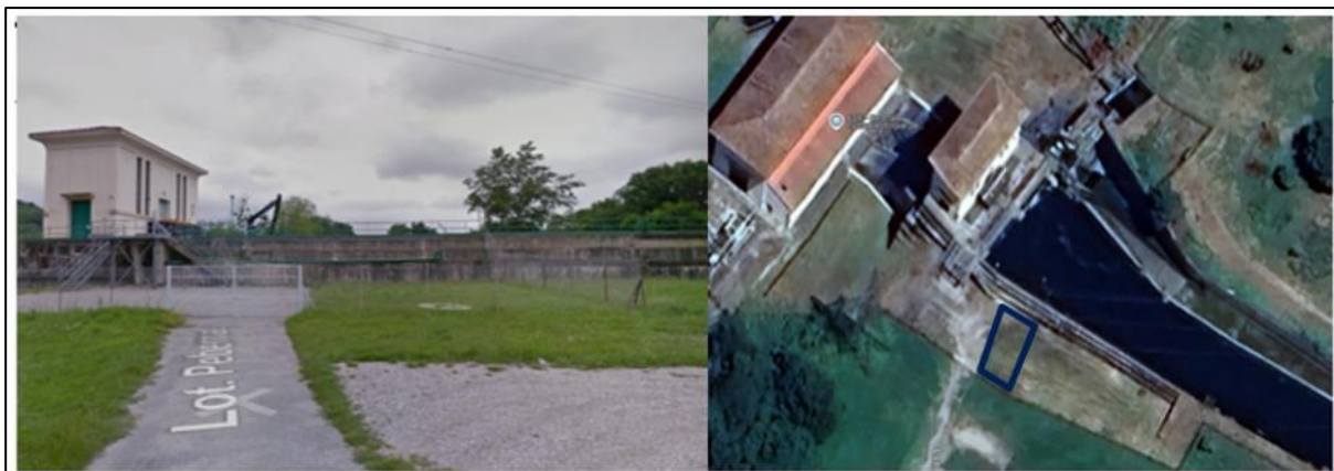
Figure 12 : Vue de la zone envisagée pour les installations de chantier.
