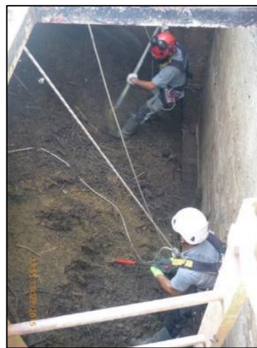
Figure 15 : Curage aux dessus des chambres-Travaux 2015
