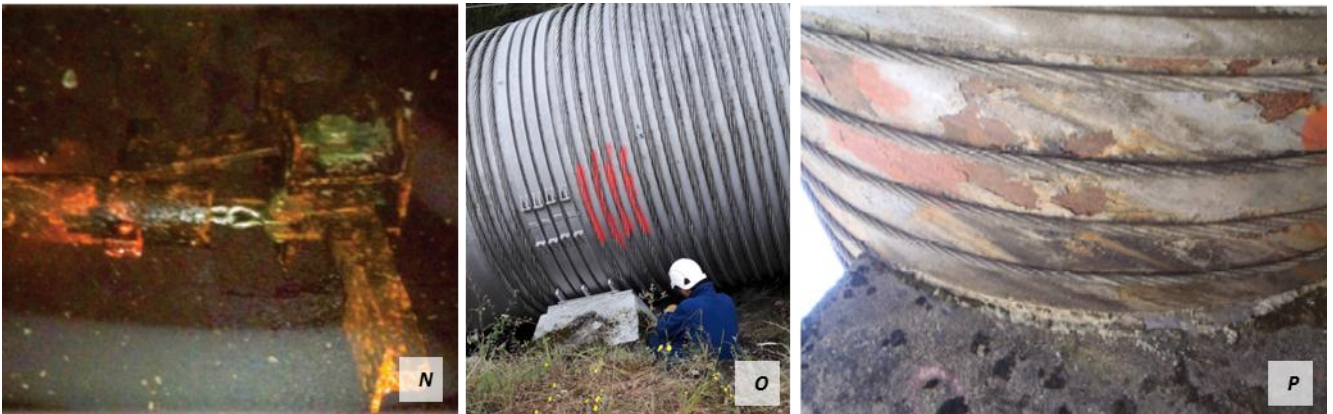
Figure 22. Opérations sur la conduite forcée n°2 du Pouget.
