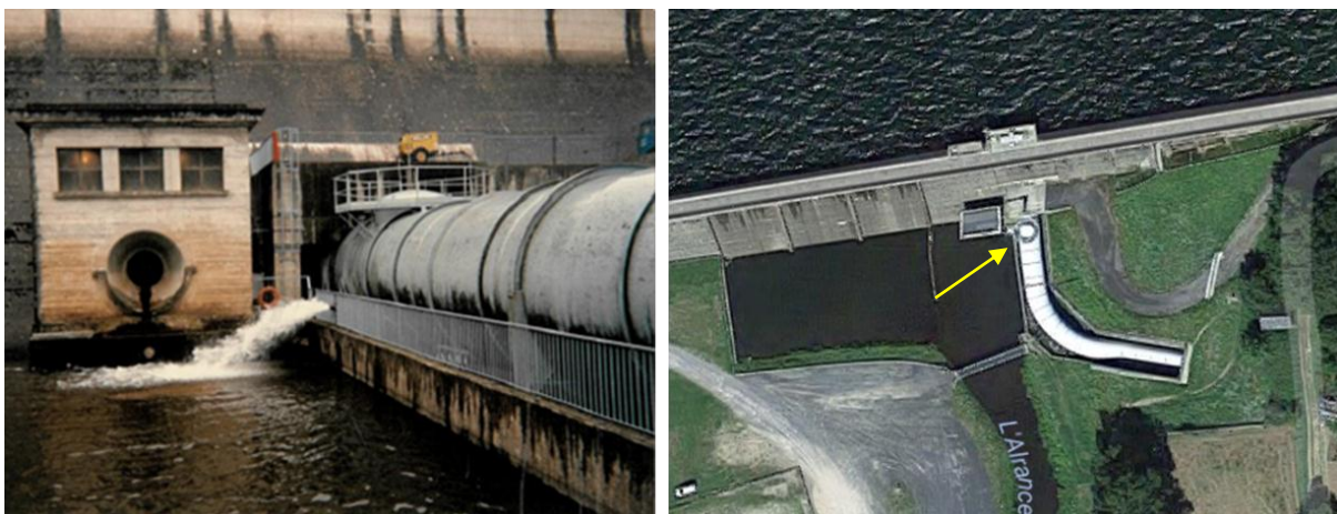
Figure 19. Restitution du débit réservé par le piquage sur la galerie 2.
