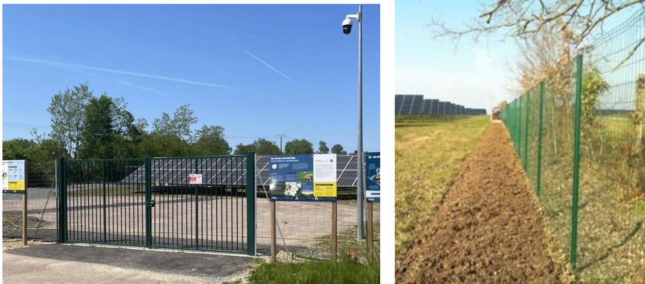
Figure 19 Photographie d'un portail et d'une clôture
