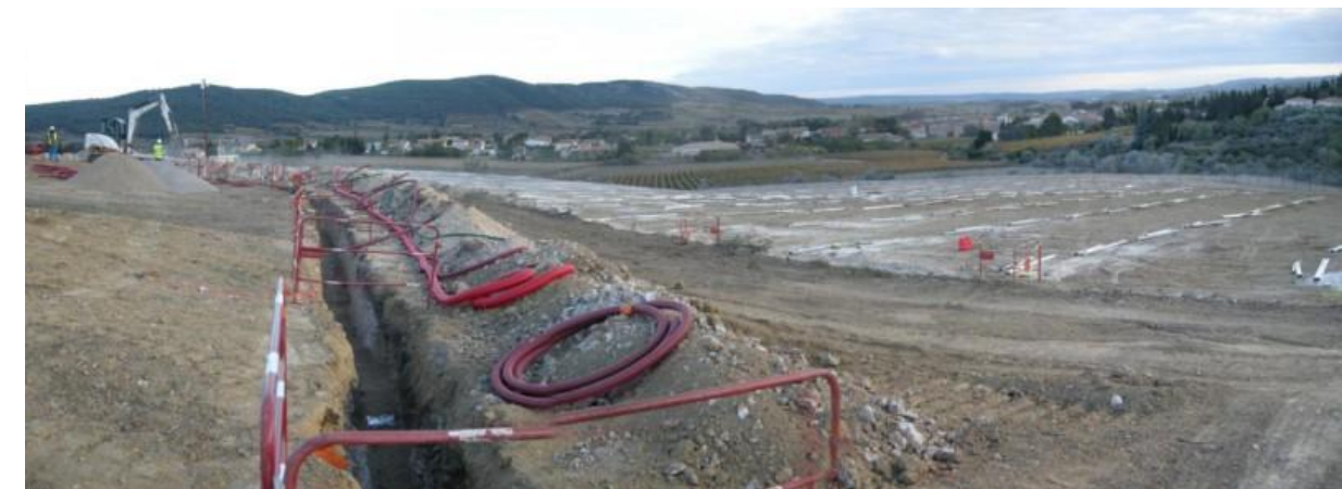
Figure 28 : Travaux de création d'une tranchée
