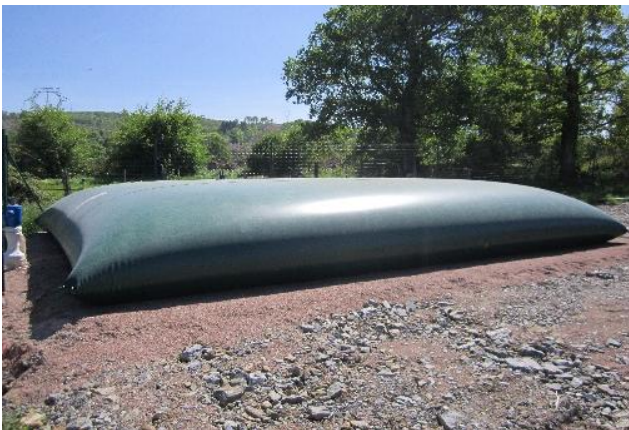
Figure 21 : Photo d'une bâche incendie
