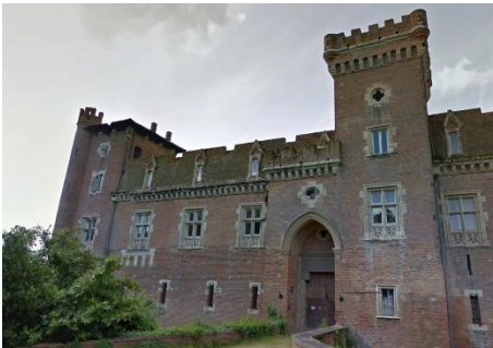
Bâtiments favorables aux chiroptères (hors site)
