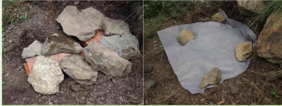
L'ensemble est recouvert de dalle ou bloc, ils doivent être assez plat et disposé en une seule couche. Par-dessus, il est placé un géo-synthétique ou géotextile en fibre naturelle (mélange lin et chanvre).
