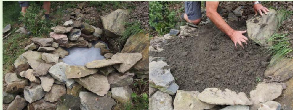
D'autres pierres et bloc plutôt plat doivent monter sur l'ensemble comme ci-dessus. Ensuite l'espace central est rempli de sable, puis il est recouvert de pierre de lauze et ensuite les tuiles peuvent également être disposés par-dessus.
