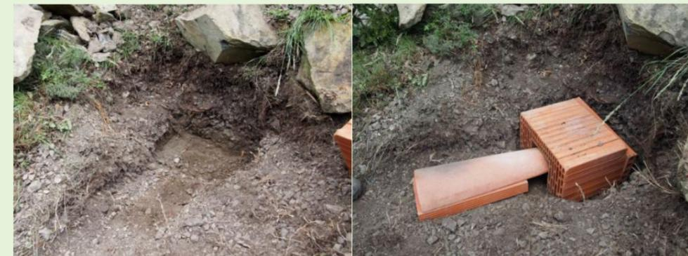
Creusement de l'abri de 60 à 80 cm de profondeur, 40 à 50 cm de large et sur 1,5 m de long à flanc de colline ou à proximité d'une zone boisée.
