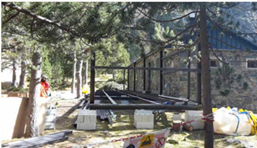
**Figure 43 : Exemple d'installation de base vie sur cale (photos du chantier du Lanoux)**
