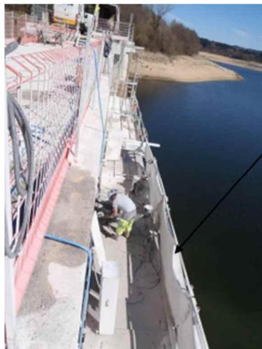
Film géotextile protégeant les protections horizontales des eaux de sciage.
