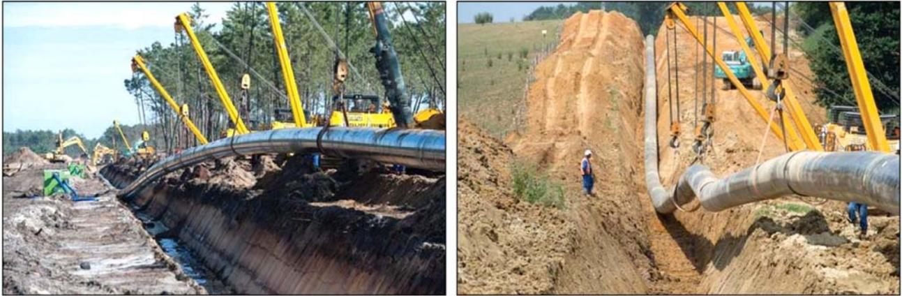
*Tronçon de canalisation mis en fouille de ligne à l'aide de plusieurs side-booms*
