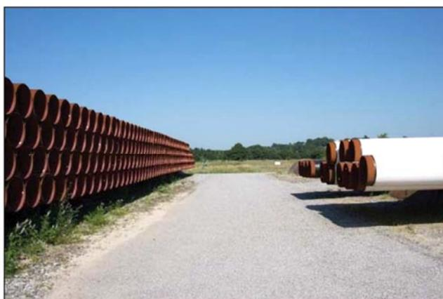
*Parc à tubes avec en noir, les tubes destinés à la construction de la ligne, et en blanc (revêtement spécifique haute résistance), les tubes utilisés pour la réalisation d'un forage horizontal dirigé*
