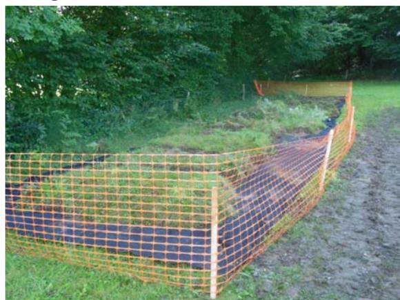
*Elles seront ensuite déposées sur un géotextile installé en dehors de la zone des travaux, dans un secteur ombragé. La zone de dépôt temporaire des plaques de terre sera délimitée par un grillage de chantier (Source GERE)*
