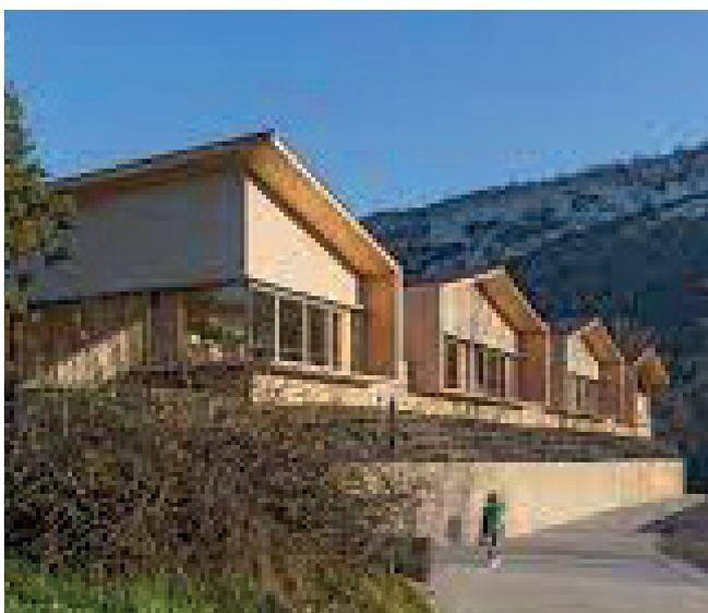
Réalisation de travaux d'économie d'énergie (isolation, chauffage, VMC) supplémentaires, par rapport à la RT 2012, afin d'atteindre la performance énergétique Bepos « bâtiment à énergie positive » à la nouvelle école de Saint\_ Antonin-Noble-Val (utilisation de matériaux biosourcés et locaux).
