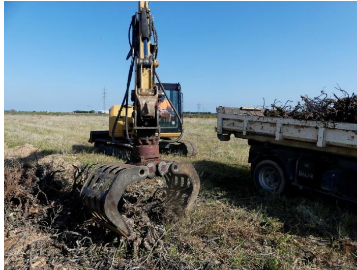
Photographie 1 : Enlèvement de ceps de vigne à l'aide d'un godet pince
