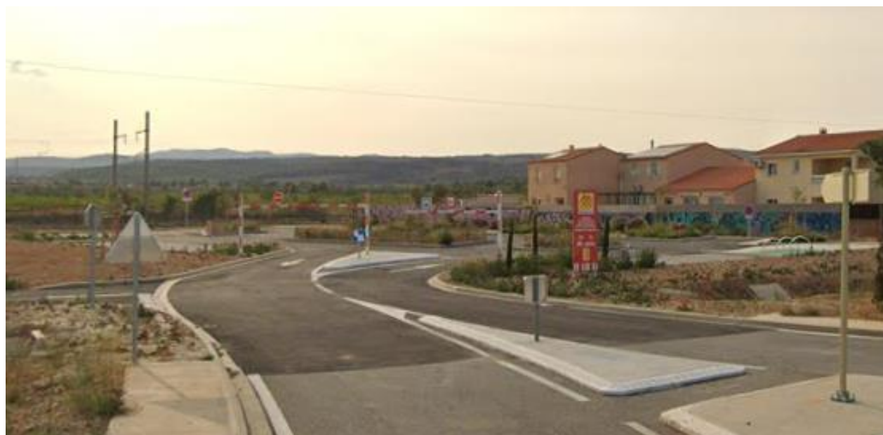
Figure 3 : Aperçu de l'aire de covoiturage de Salses-le-Château sur laquelle sera placée une base vie du chantier.
