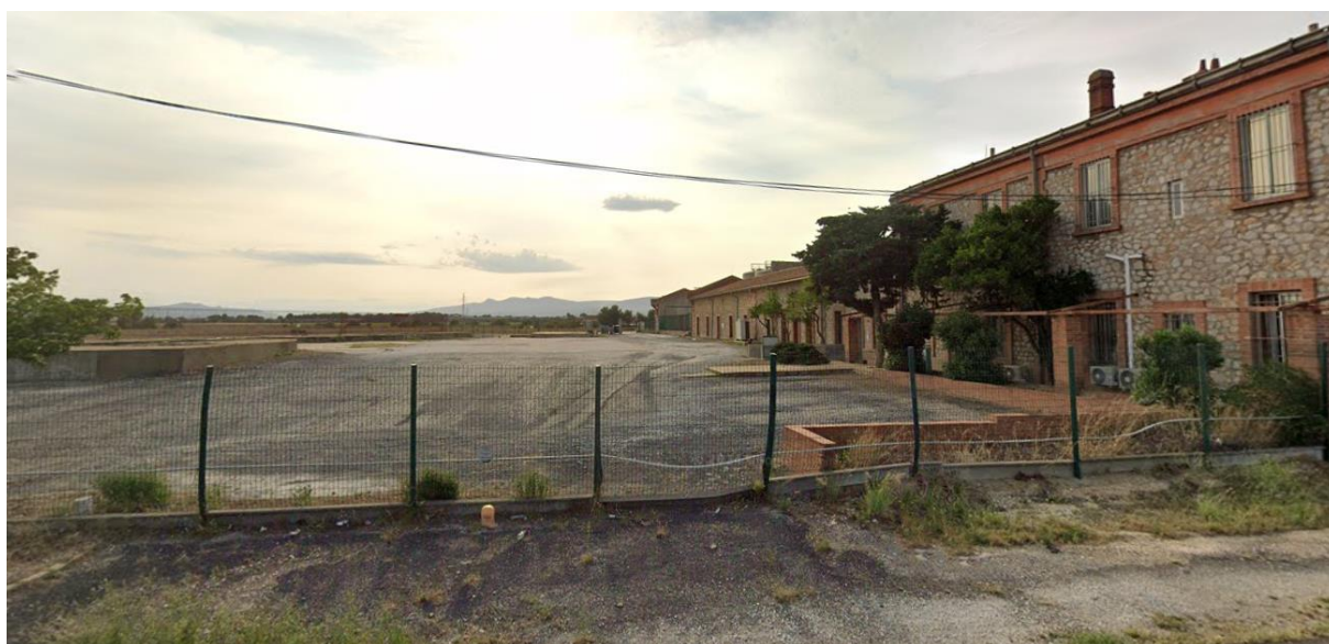
Figure 5 : Aperçu du délaissé routier des caves Arnaud de Villeneuve à Rivesaltes sur laquelle sera placée une base vie du chantier.
