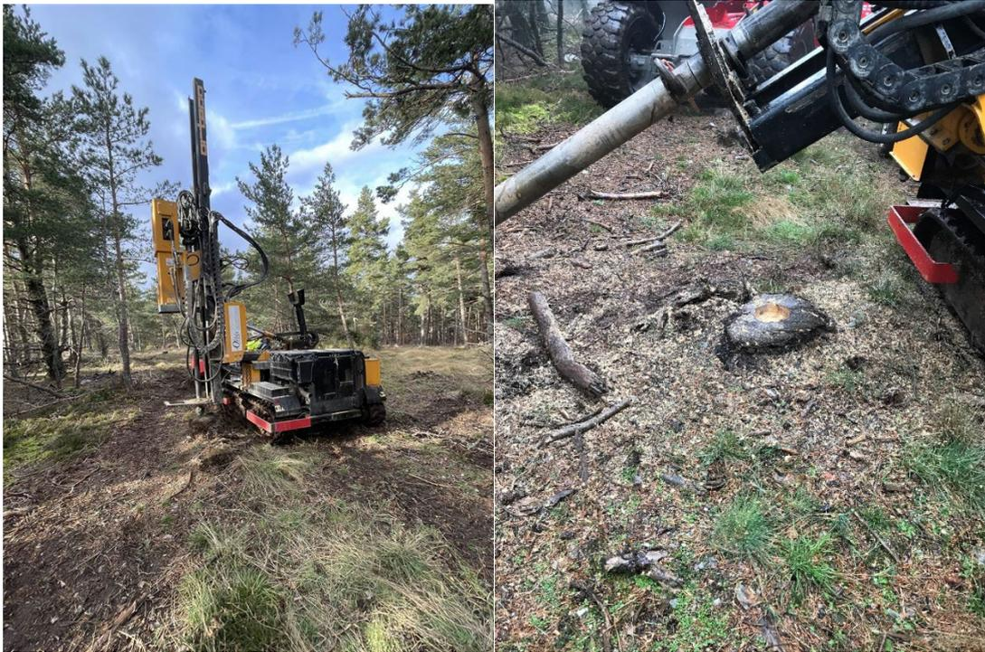
Figure 6 - Tests réalisés sur une souche pour le préforage mécanique et la mise en place des pieux
