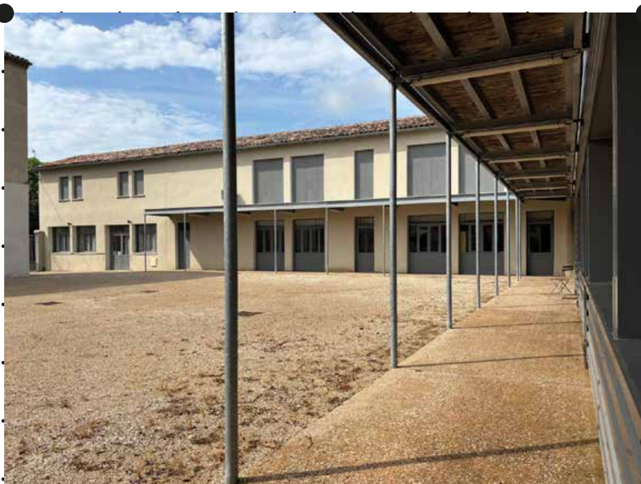
Depuis la coursive, vue vers la sortie et le bâtiment réhabiliter en bureau.
