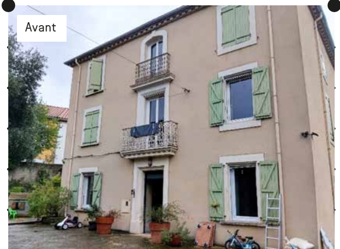
État avant travaux de la maison vigneronne Crédit photo: EPF Occitanie
