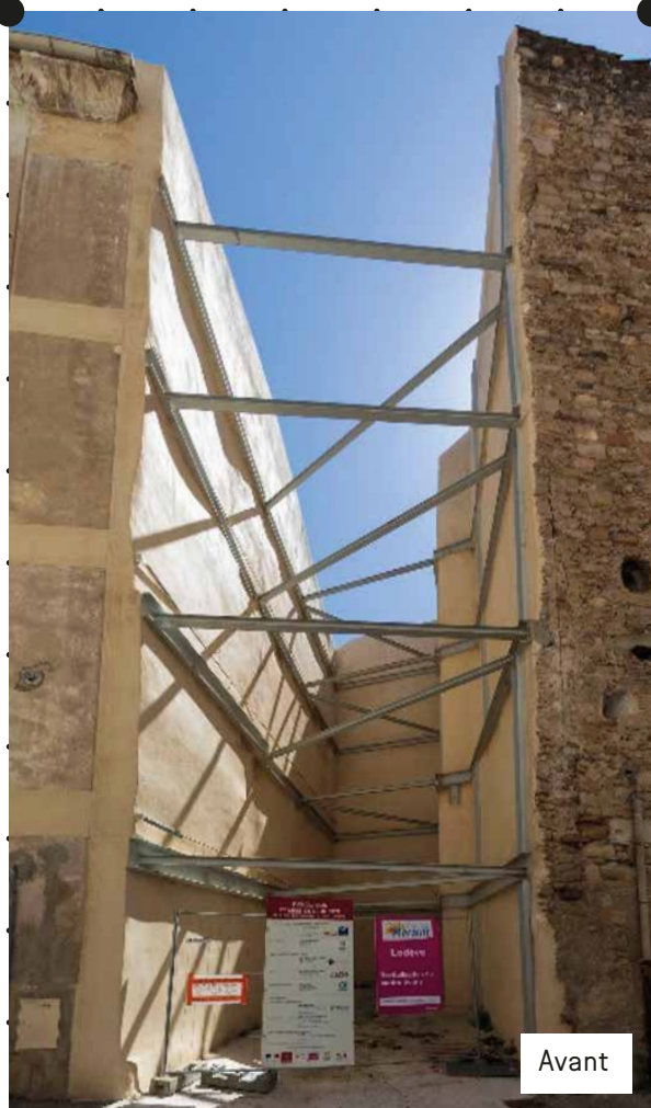
Curetage et déconstruction de l'îlot Saint-Pierre
