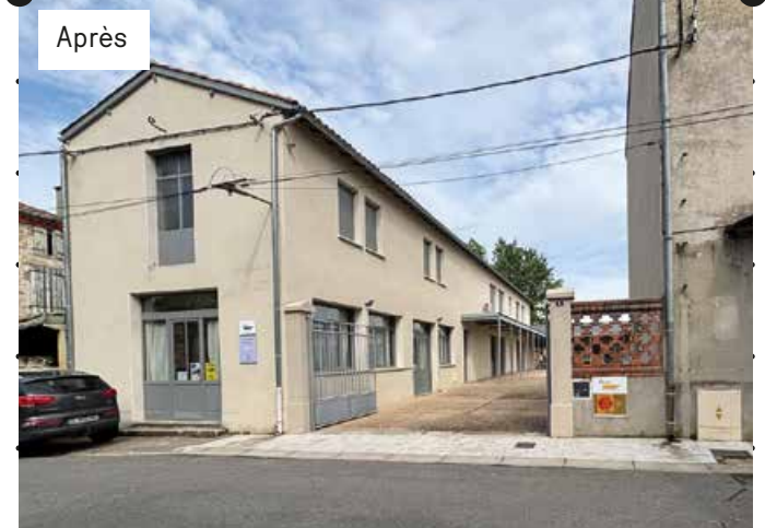
L'usine Decalux après réhabilitation en 2024
