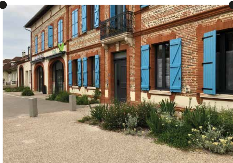
Un espace public traité au pied des logements et des commerces
