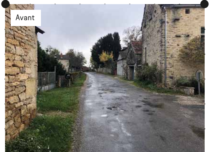
Avant : une rue uniformément revêtue d'enrobé © Atelier Palimpseste
