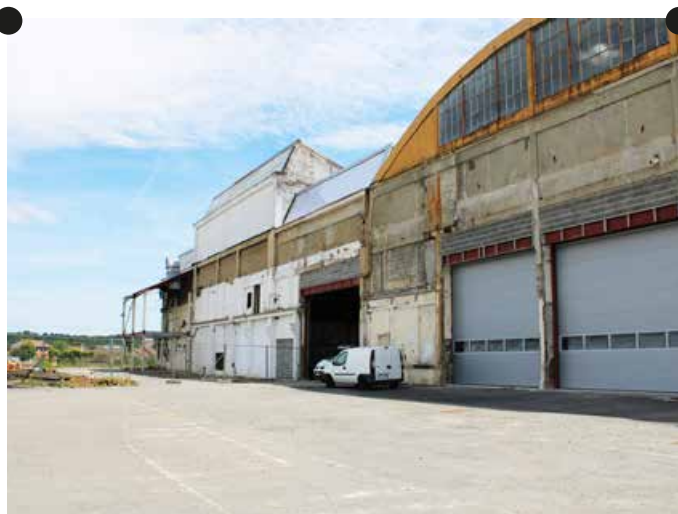
Façade du bâtiment principal en cours de réhabilitation Crédit photo: SCI 1921
