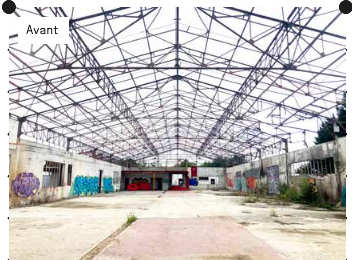
Halle en cours de réhabilitation Crédit photo : Le Lien
