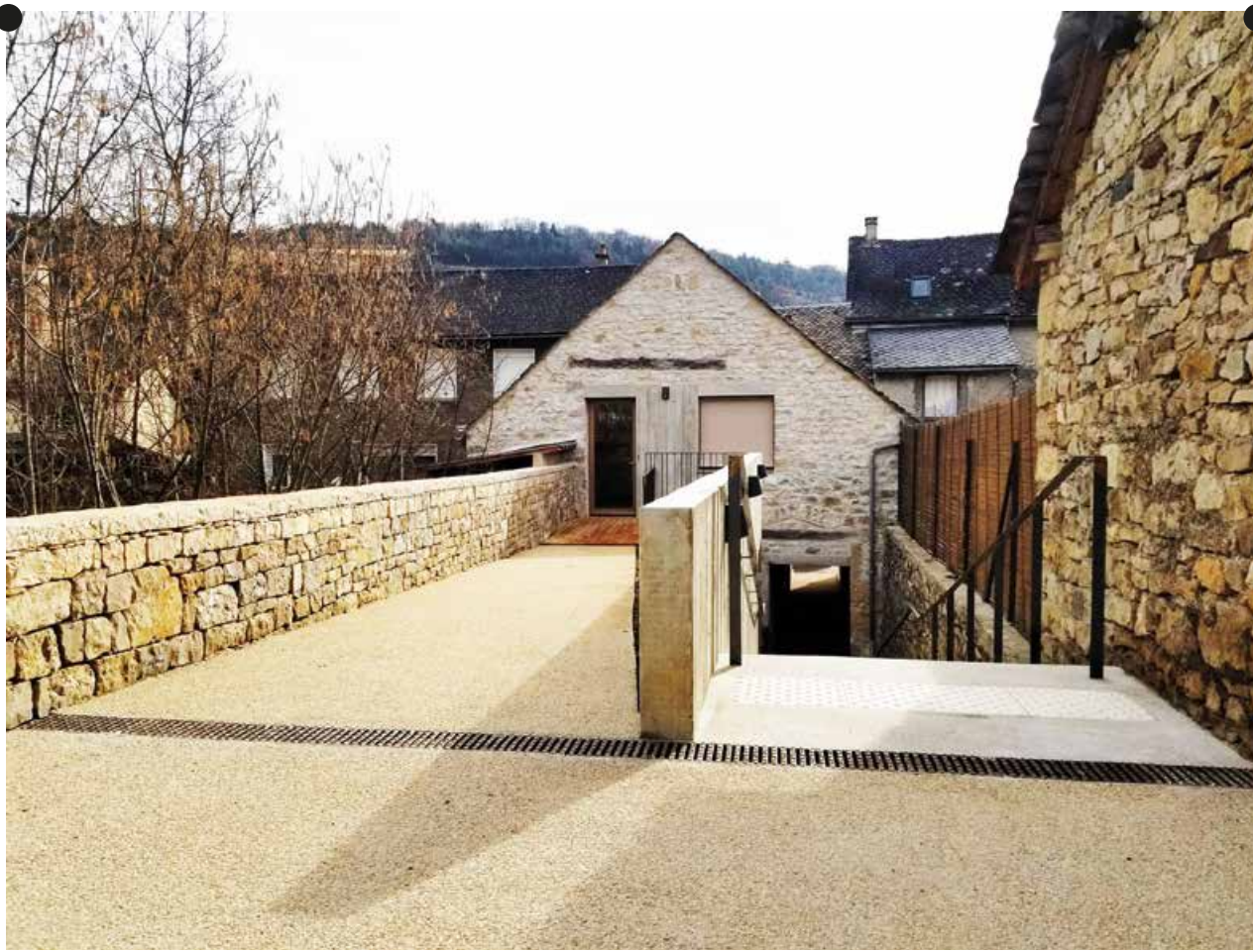
Vue depuis l'avenue de la République : la passerelle et la venelle
