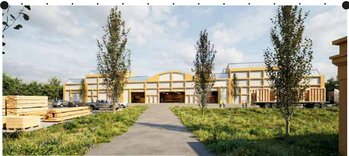
Image d'ambiance de la façade du bâtiment principal Crédit photo: 360° architecture
