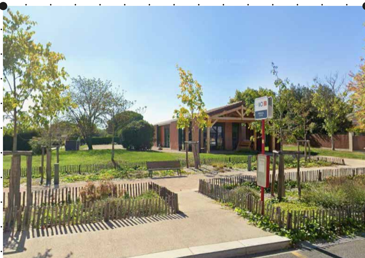
Aménagements piétonniers communiquant avec le bâtiment
