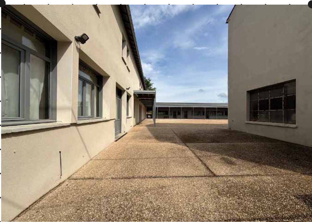
Depuis la rue l'entrée, la cour met en valeur les bâtiments de bureau.
