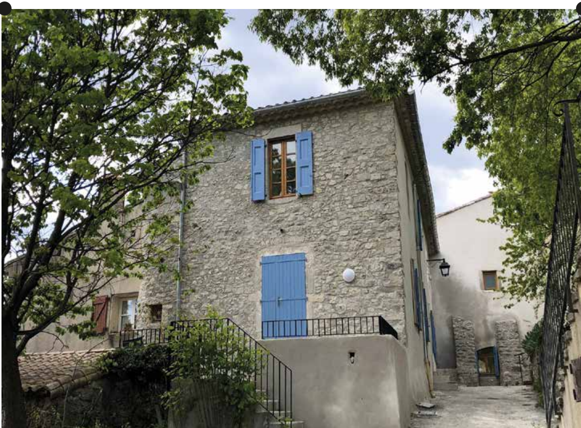
Logements communaux rénovés
