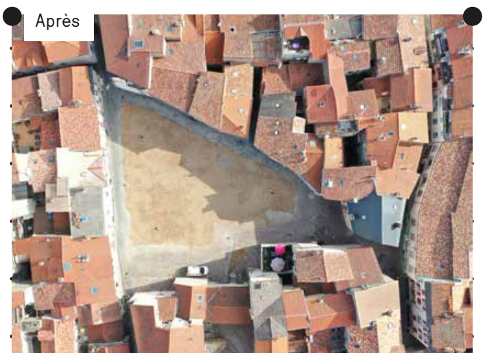
Après Îlot Sablons après démolition Crédit photo: DDT12
