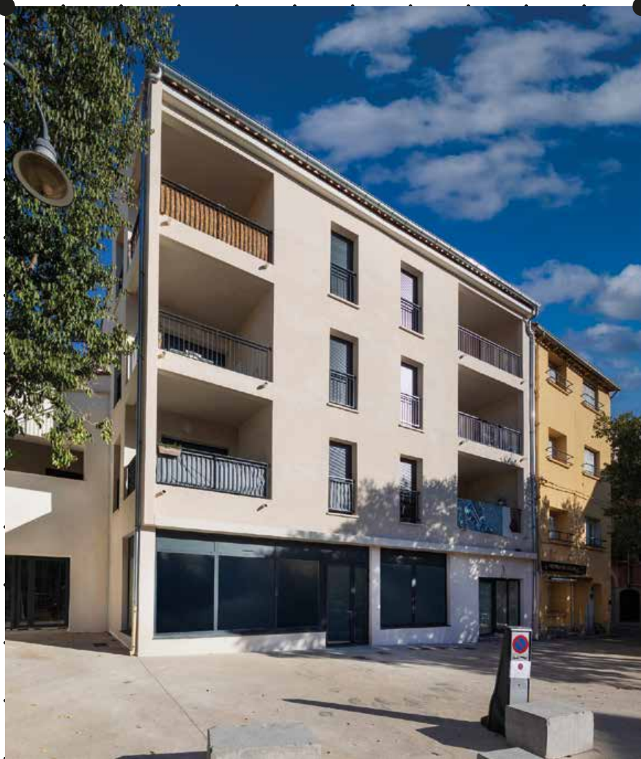
Façade principale de l'îlot de la place du Marché
