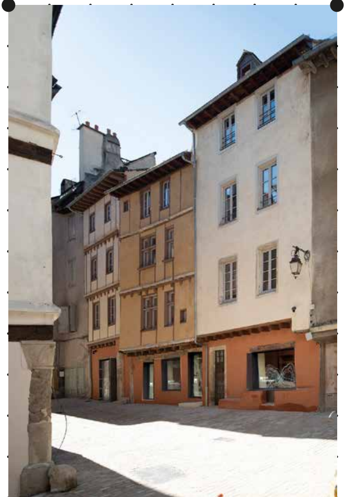
Entrée du musée : les façades des maisons Seguin et Zucchi sont soigneusement restaurées en tenant compte des vestiges visibles « in situ ».
