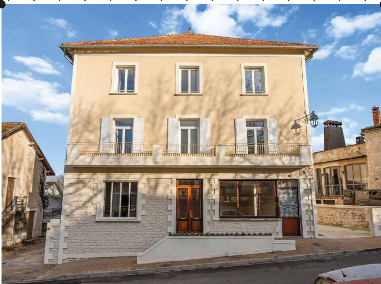
Façade sur rue, commerce au rez-de-chaussée, appartement aux étages
