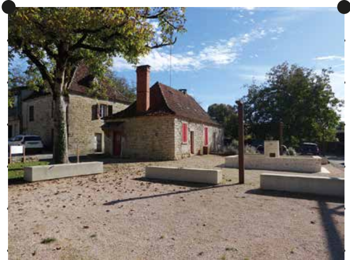
La place publique qui articule la maison existante et la résidence est un lieu convivial apprécié par les habitants du village. © Caué du Lot
