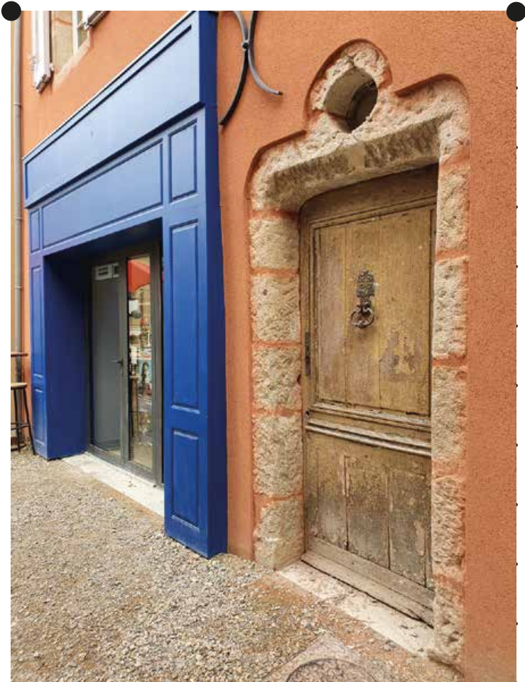
La nouvelle devanture commerciale et la porte ancienne restaurée
