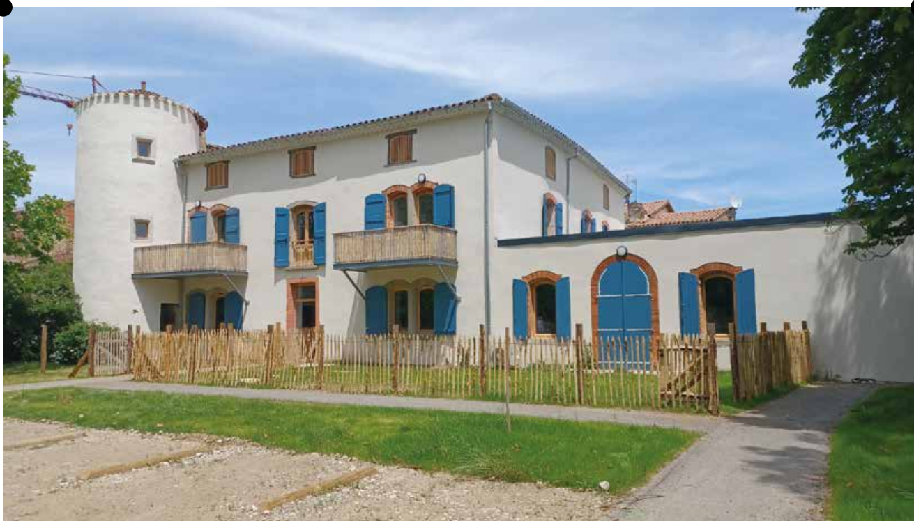
La maison réhabilitée en logements
