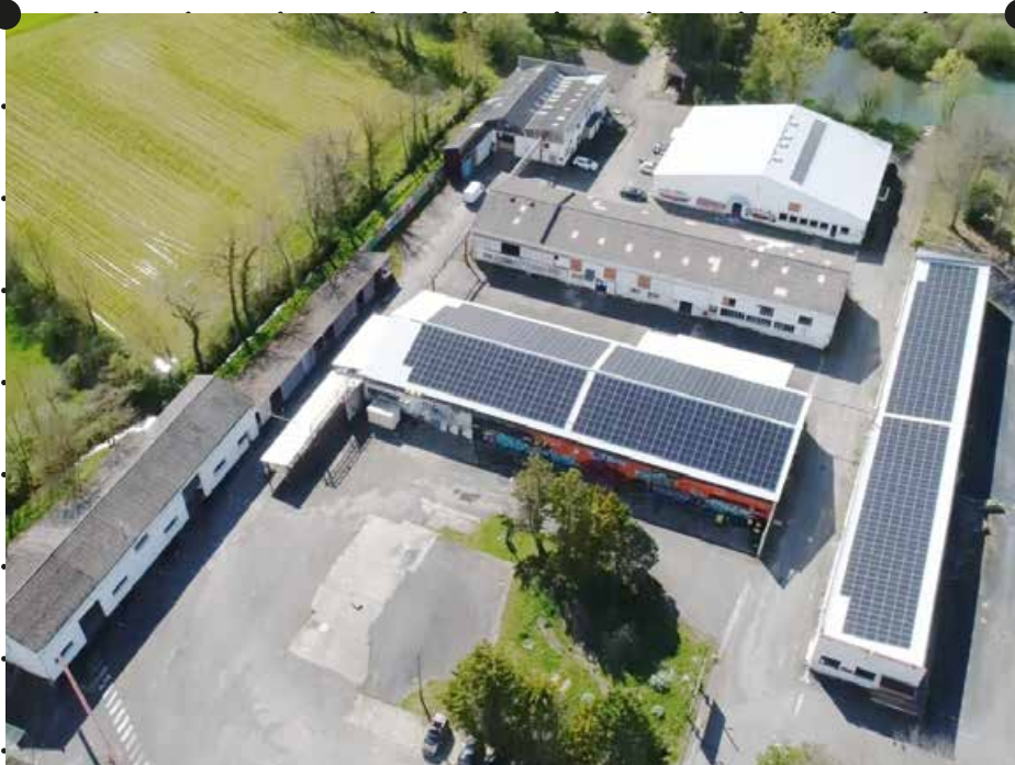
Halle couverte / Bâtiment A / Skatepark / Ecole ETRE / UCJ Crédit photo : Le Lien
