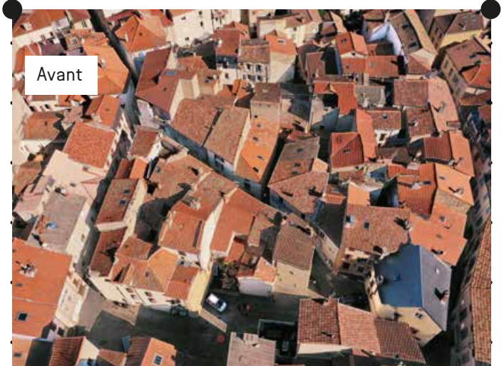
Avant Îlot Sablons avant démolition Crédit photo: DDT12
