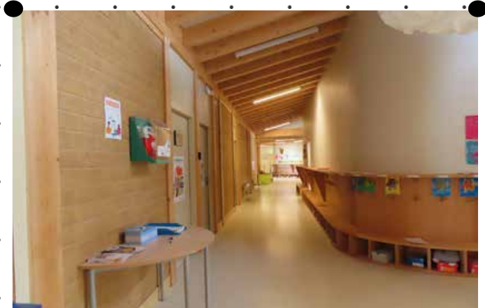
L'intérieur de l'école : structure bois, murs en terre crue, mobilier bois
