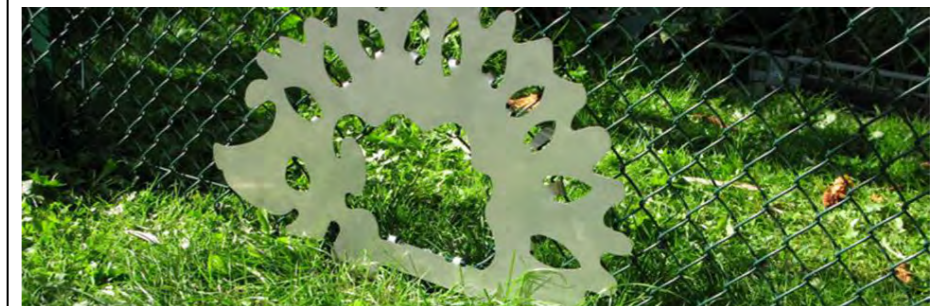
FIGURE 71 : EXEMPLE DE PASSAGE A HERISSON A INSTALLER SOUS LES CLOTURES DES BASSINS
