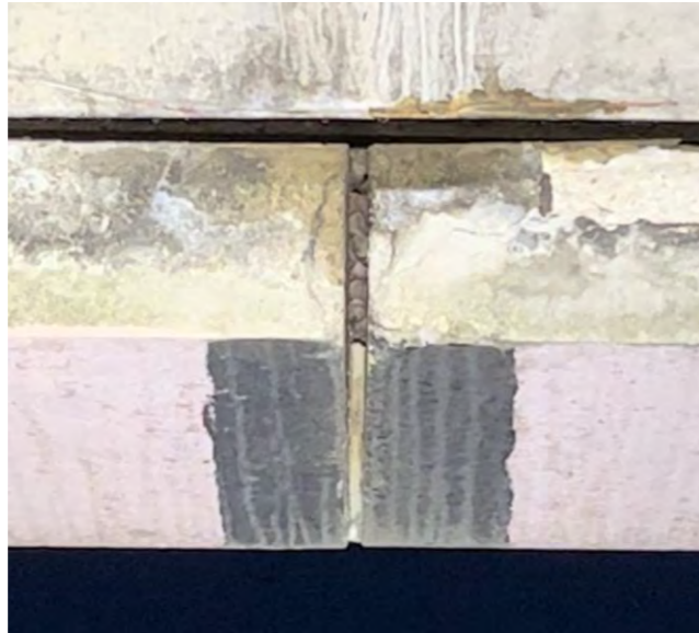
Figure 5 : Individus de Pipistrelle pygmée (adultes et jeunes) au sein d'une culée du pont de Girac (Pierre GAUTHIER, Egis, 11 juillet 2023)
