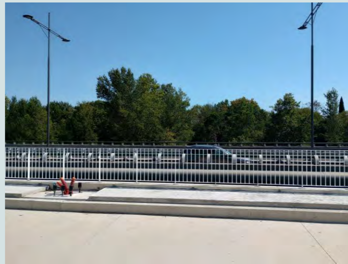
Voies de tramway (en construction) et route départementale RM65
