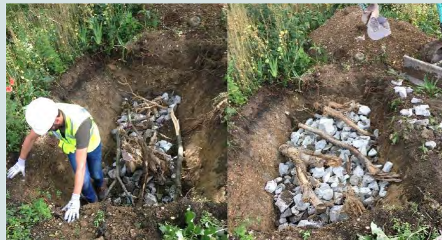
Figure 43 : Exemple de remplissage d'un hibernaculum (Egis)
