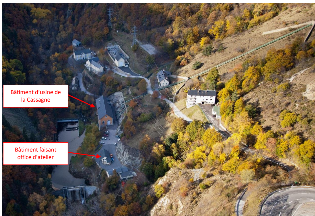
Figure 2 : Photo du bâtiment d'usine et ses annexes dont le bâtiment atelier à démolir – Vue aérienne du site
