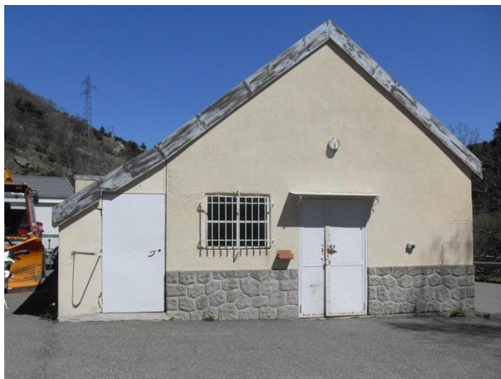
Figure 4 : Photo du bâtiment atelier existant à démolir
