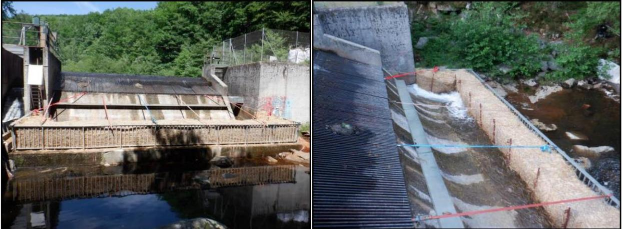
Figure 9 | Exemple de bassin de filtration en ballot de pailles
