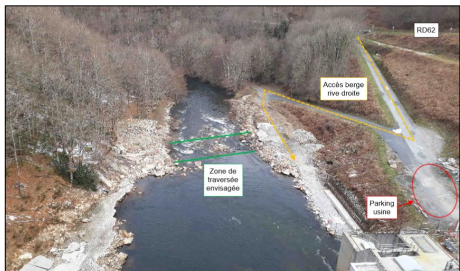
Figure 13 : Accès des engins aux zones de travaux
