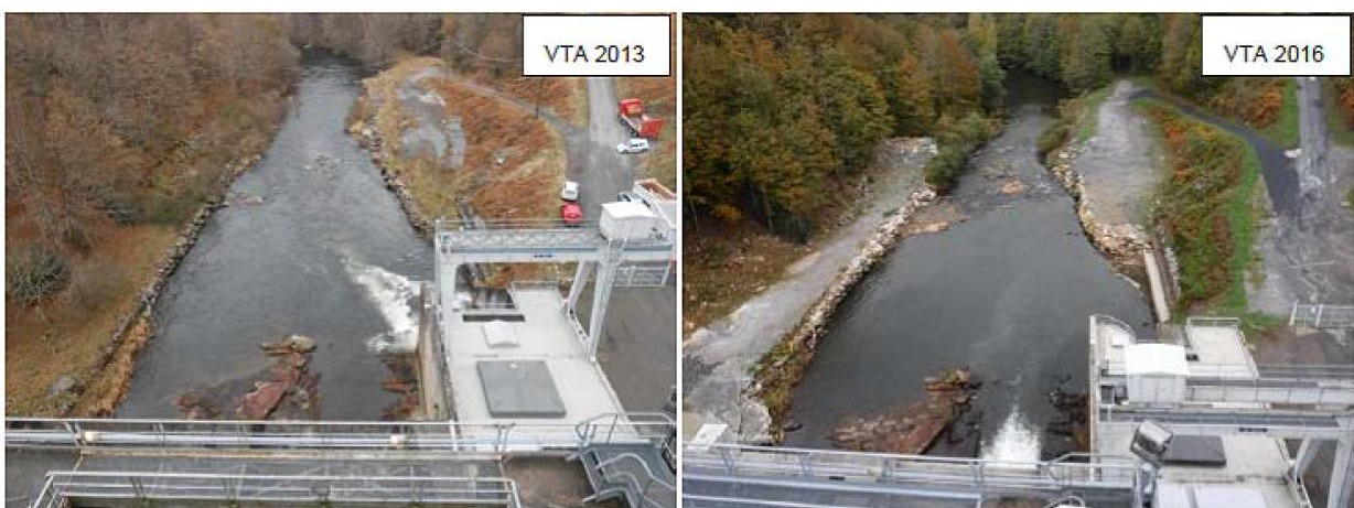
Figure 6 : État des berges en aval du barrage de la Ravière avant la crue de 2017
