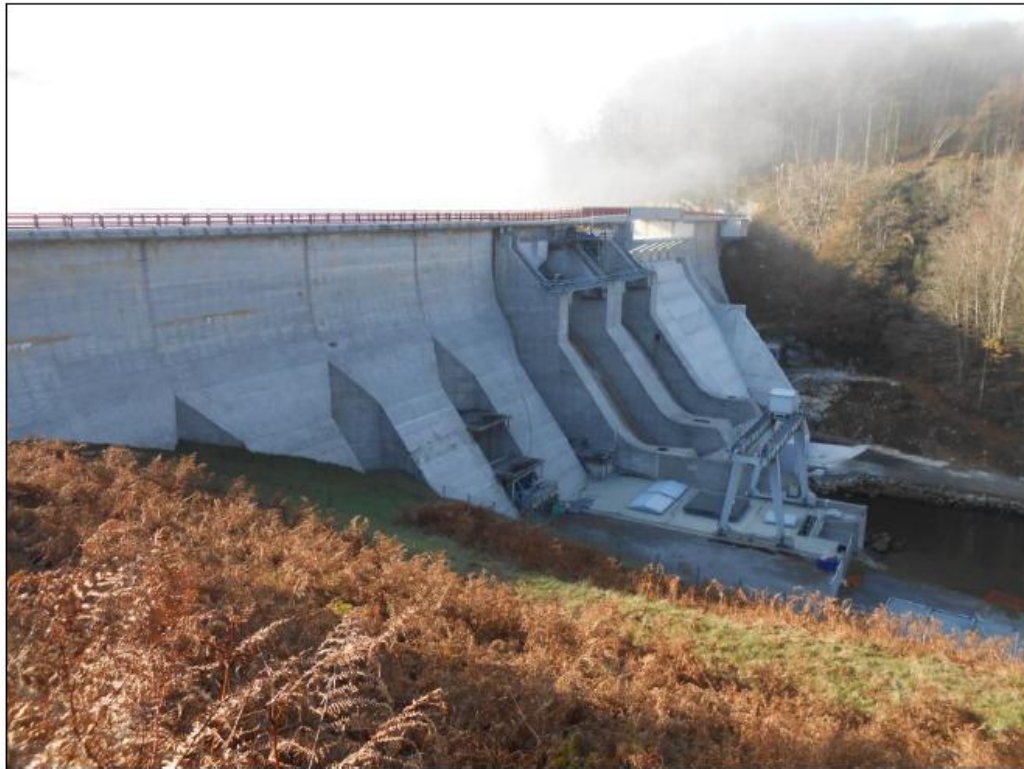
Figure 4 : Photographie du barrage de La Ravière (depuis aval rive droite)
