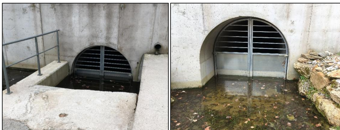
Figure 10 : Accès à la galerie G1 (gauche) et à la galerie G2 (droite)
