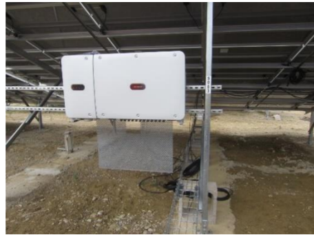
Figure 14. Exemple d'onduleur décentralisé (source NEOEN)
