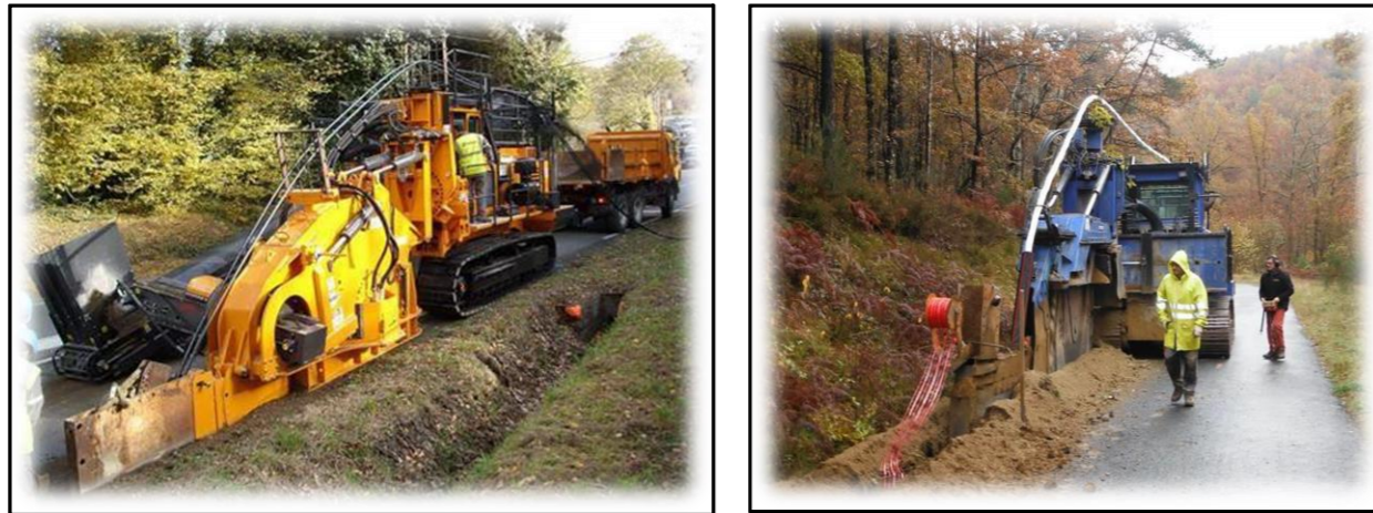
Figure 21. Trancheuse | Exemple de pose de câble à la trancheuse (source : NEOEN)
