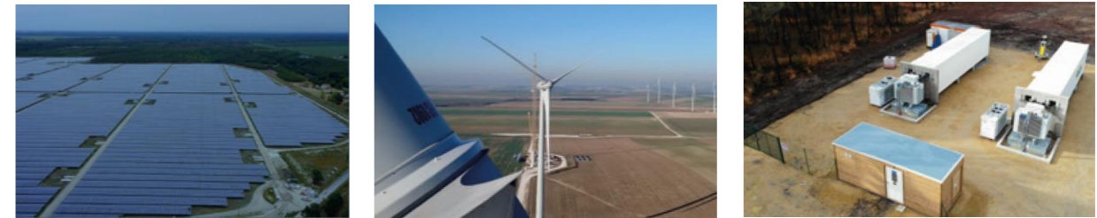
Figure 5. de gauche à droite, Centrale Solaire de Cestas (300 MWc), Centrale Eolienne de Bussy-Lettrée (26 MW), et Azur Stockage (6 MW, 6MWh) (source : Neoen, 2019)
