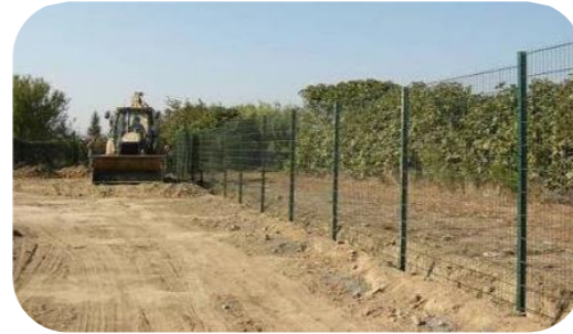
Figure 24. Pose des clôtures (source : Neoen)
