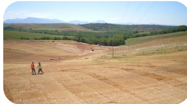
Figure 25. Piquetage (source : Neoen)
