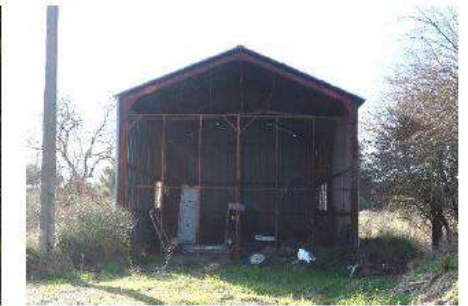
Bâtiment en limite Ouest du site
