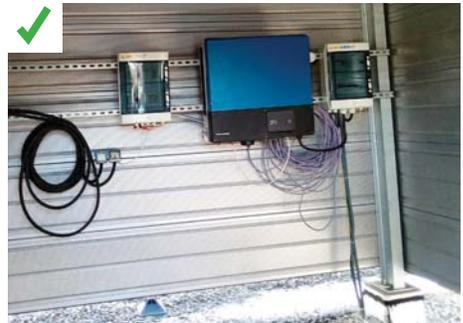
Situé en toiture, ce local est largement ventilé sur sa partie basse, avec un espace d'environ 30 cm sur tout le pourtour du local. Le brassage d'air maintient une température adéquate.
