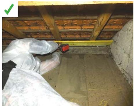
Mise en place de déflecteurs en bas de toiture pour maintenir la continuité de la lame d'air ventilée sous les tuiles.
