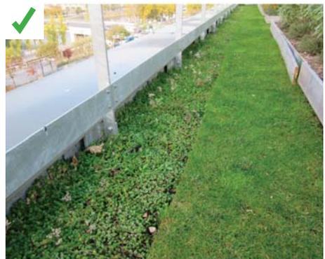
Bande stérile aménagée en utilisant des caissettes à planter modulaires en plastique. Le couvert végétal est maintenu jusqu'en limite d'acrotère. En cas de besoin d'accès à la couche d'étanchéité les caissettes sont facilement amovibles.
