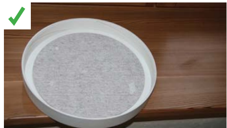
Mise en place d'un filtre acoustique à l'intérieur du capot de la bouche du module push-pull. Fourni par le fabricant, il permet une atténuation du bruit extérieur de 2dBA sans modifier les débits d'air. © AQC
