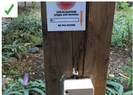
Installation de pièges anti-termites sur une structure à ossature bois. © AQC
