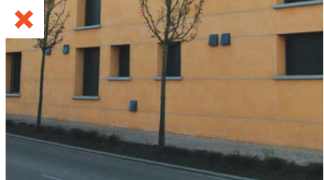
La présence de modules de ventilation sur cette façade entraîne une gêne à l'intérieur des locaux donnant sur la rue très passante. © AQC
