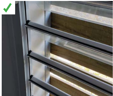
Mise en œuvre d'une double peau de type bardage à lames de bois horizontales ajourées, limitant l'impact des pluies battantes sur les menuiseries et permettant la ventilation naturelle en cas d'intempérie. © AQC
