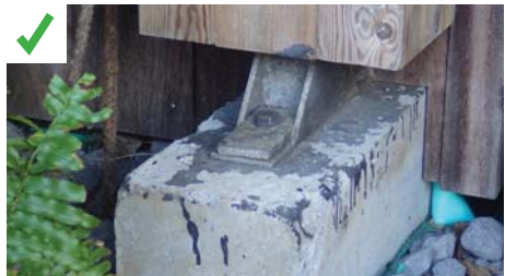
Mise en place d'une barrière physique anti-termites (film polyane vert sur la photo) entre le sol et le bâtiment limitant la propagation des termites. © AQC
