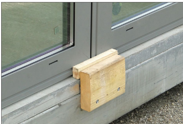
Des cales de bois empêchent l'ouverture intempestive des menuiseries.
