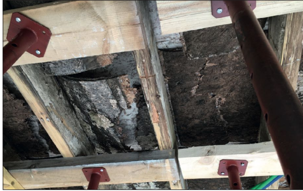
Constat de la dégradation totale du plancher (solivage et panneaux).
