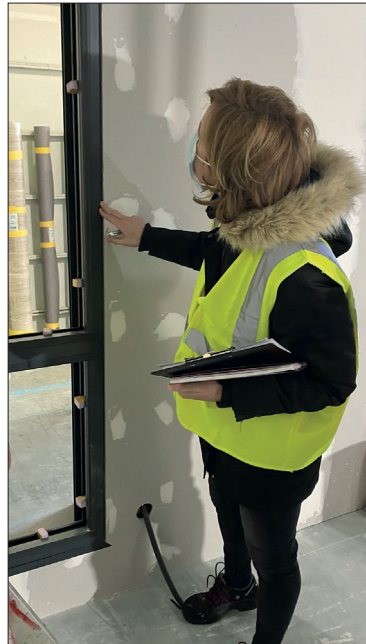
Contrôle technique des menuiseries d'un module dans une usine du groupe Solfab Construction Modulaire.
