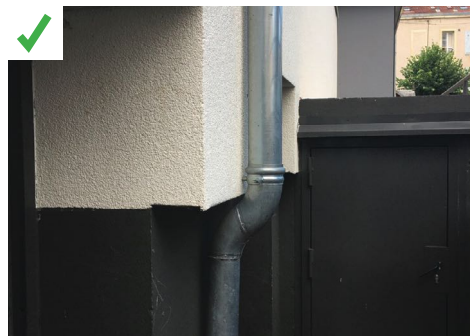
La descente d'eau pluviale a été déposée, puis refixée sur la façade. Un coude de raccordement en bas d'ITE permet une connexion au collecteur des eaux pluviales. ©AQC
