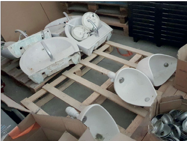
Démolition de l'ERP Pleyel City Beast pour Solideo en septembre 2020 en vue de la construction du Village des athlètes pour les JO 2024. Ici, les équipements sanitaires triés par éléments.
