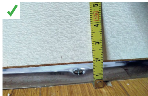
Le détalonnage de la porte de la cuisine est de 2 cm, conformément aux règles de l'art. ©AQC
