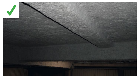
Les poutres en béton de ce garage ont été isolées sur toutes leurs faces (procédé de projection de laine minérale avec liants). ©AQC
