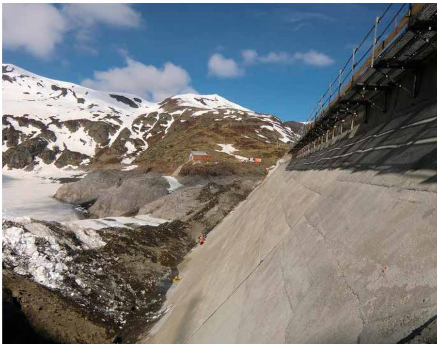
server le parement amont du barrage et la prise d'eau usinière, parties de l'ouvrage habituellement inaccessibles. La galerie a été remise en eau le 2 mai, pour une remontée progressive du lac.
