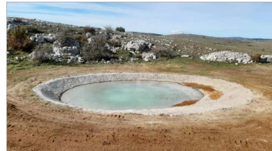
Photo 19 - Lavogne créée à Hures-la-Parade (Parc National des Cévennes) revêtue d'une forme de ciment fabriqué à partir de matériaux locaux (gravillons en calcaire concassé) pour un rendu proche des terrains naturels (source : Yann Dissac – PNC).
