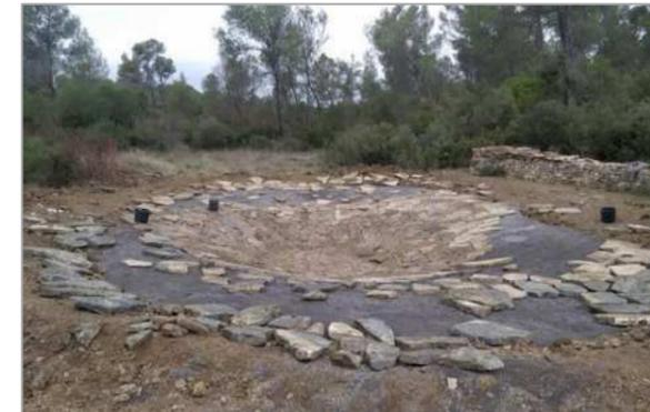
Photo 22 - Lavogne en opus incertum – une mosaïque imparfaite, avec des espacements entre les dalles afin de favoriser le développement de la vie aquatique
