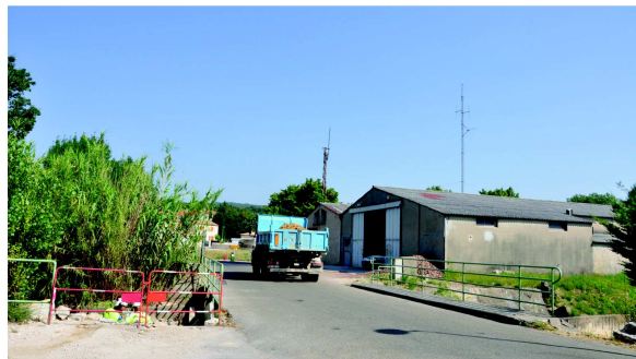
La qualité du bâti sur les seules zones constructibles du site
