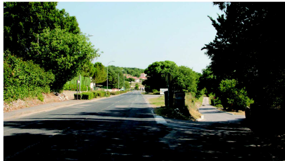
Les accès aux nouveaux équipements devront être améliorés
