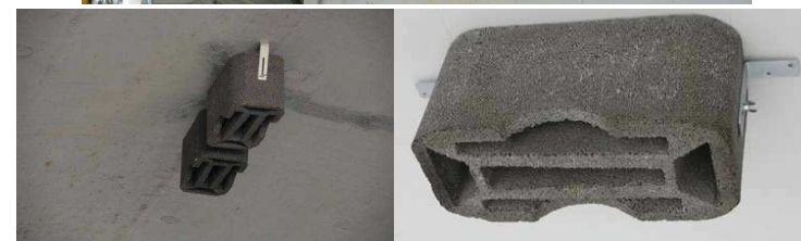
Illustrations des différents types de gîtes artificiels pouvant être installés sous les ouvrages (Sources : CEN Midi-Pyrénées ; Nature Environnement 17 ; Charente Nature ; www.nichoirs-schweqler.fr )
