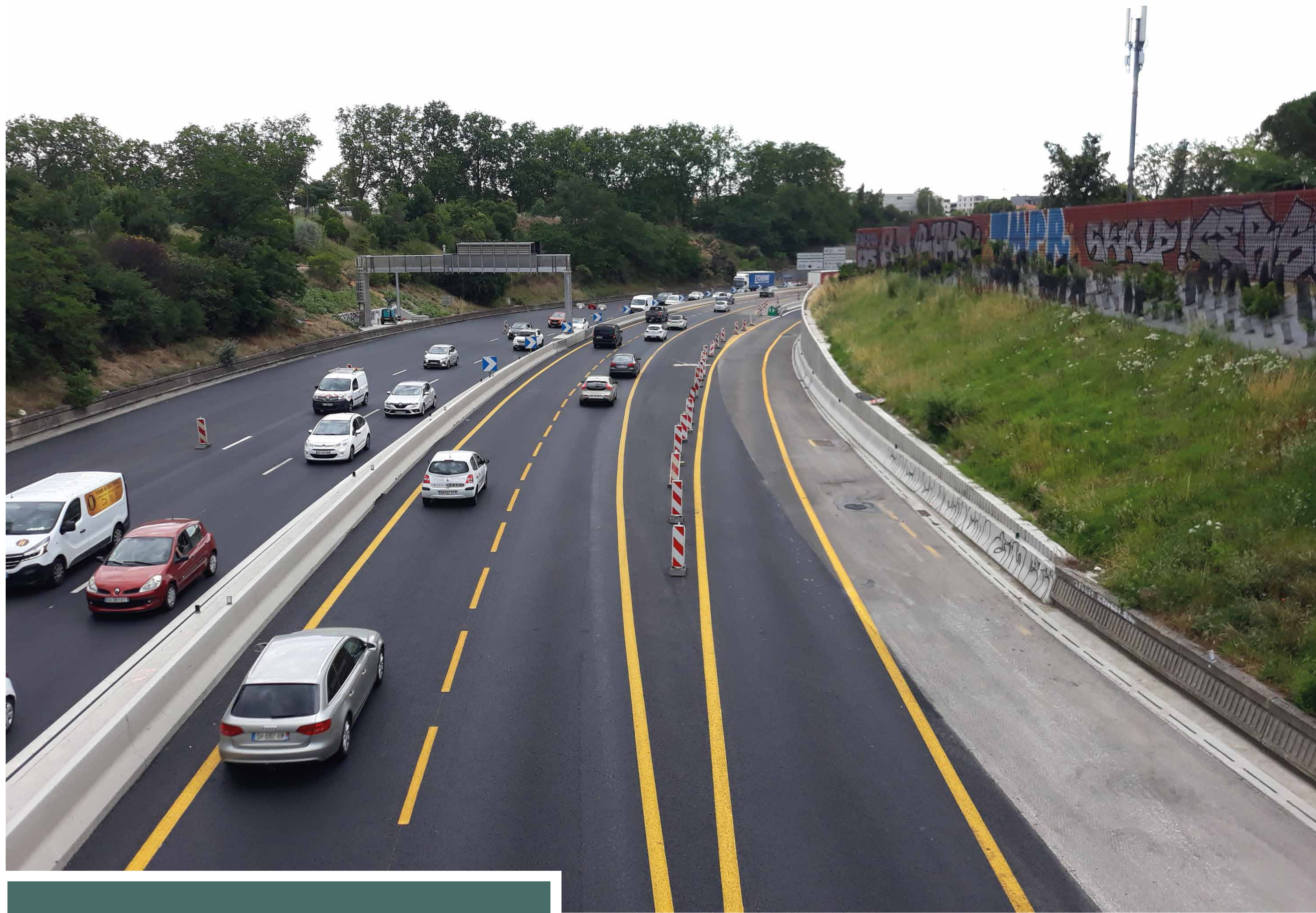
Avancée des travaux au 15 juin 2021
