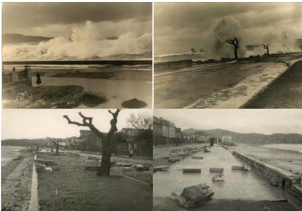
Tempête de 1951 – Hendaye – Source Caractérisation de l'aléa Submersion marine dans le cadre du PPRL du secteur d'Hendaye – BRGM / RP – Décembre 2016
