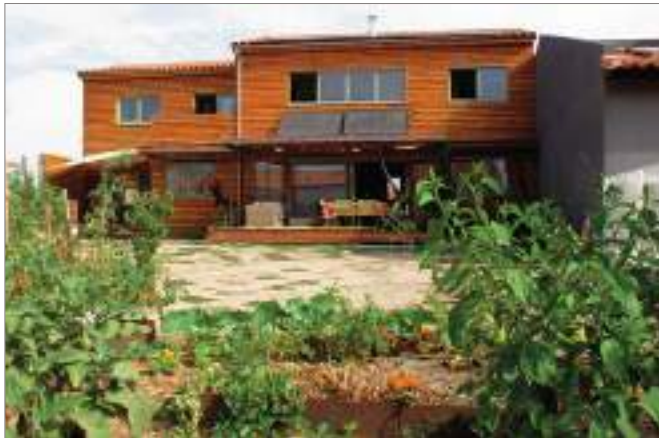
Maison BBC Effinergie à Elne
