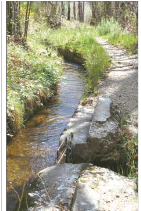
/ Canal d'irrigation approvisionnant mosset /
