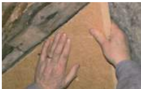
Isolation avec panneaux en fibre de bois
