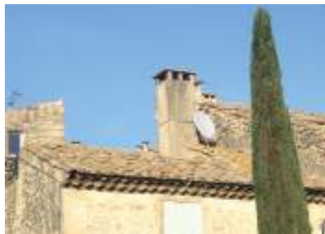
Débords de couverture avec génoise à deux rangs et deux filets
