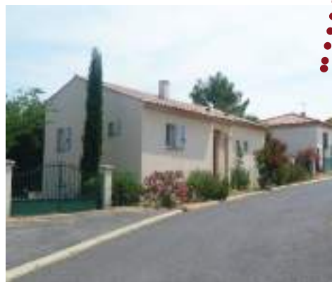
Bon exemple d'enduit taloché fin de teinte claire.
