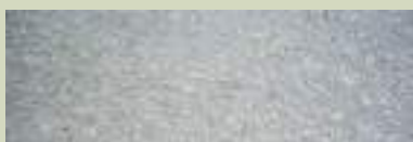
Béton désactivé ou béton de site
