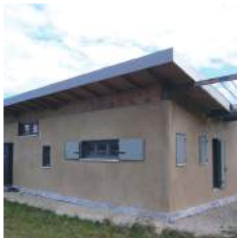
Parois en paille-terre, Sophie Lowsky, architecte
