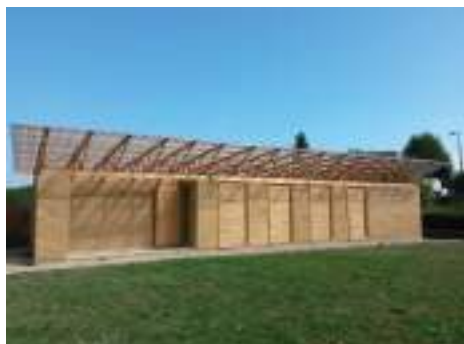
Grands Ateliers de L'Isle-d'Abeau : parois en terre crue banchée (pisé)
