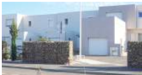
Ici des gabions, non pas utilisés en parement de façades mais pour réaliser des murs de clôture
