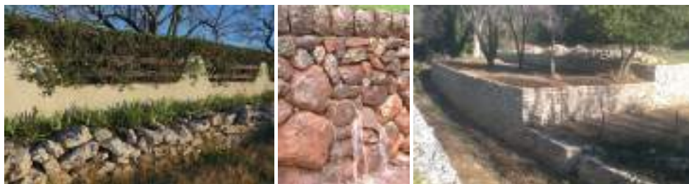
Murets de clôture ou de soutènement
