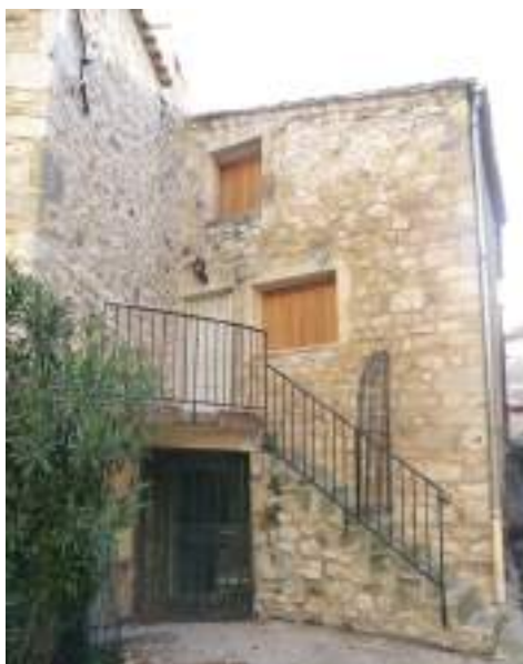
Garde-corps métallique à barreaudage simple
