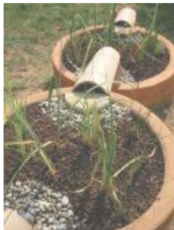
Les bassins-filtres une fois aménagés (remplis de gravier de pouzzolane) et plantés.
