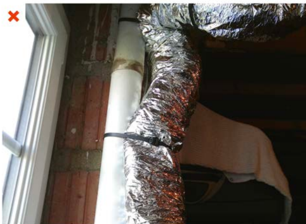
L'emploi de gaines souples en traversée d'étages est à éviter. Leur fixation est sujette à écrasement et les changements de direction entraînent des pertes de charge importantes. ©AQC
