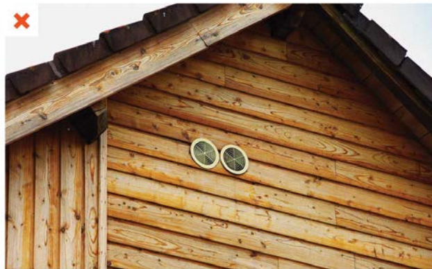
La prise d'air neuf et le rejet d'air vicié sont juxtaposés ce qui peut induire une réintroduction de l'air vicié dans le bâtiment. ©AQC
