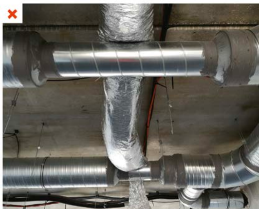
Sur cette photographie, on constate des réductions de section et des pincements de gaines. Les contraintes du site et l'encombrement des réseaux aérauliques n'ont pas été appréhendés. ©AQC
