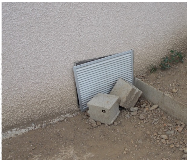
La prise d'air neuf et le rejet d'air vicié sont juxtaposés ce qui peut induire une réintroduction de l'air vicié dans le bâtiment. ©AQC
