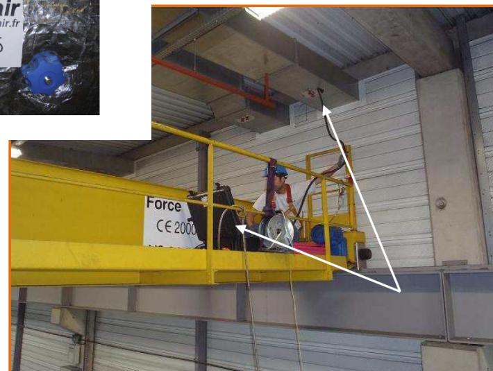
Passage du robot dans les gaines. Le robot va brosser les parois pour que les poussières soient aspirées par la centrale.
