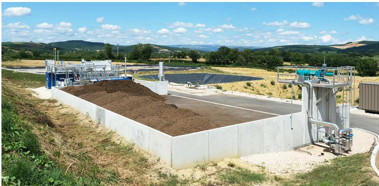
Installation de méthanisation - zone de dépôt du digestat - CC Métha à Palmas-d'Aveyron (Aveyron)
