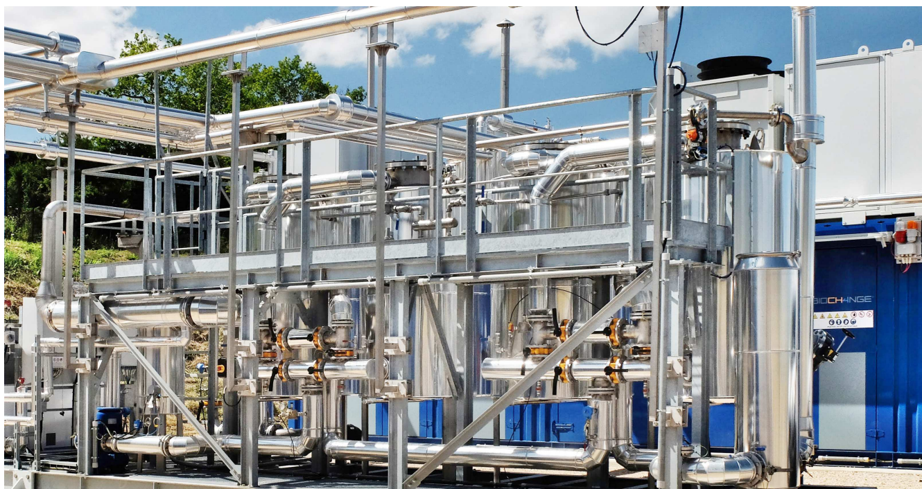
Installation d'injection de biogaz dans le réseau de distribution - CC Métha à Palmas-d'Aveyron (Aveyron)
