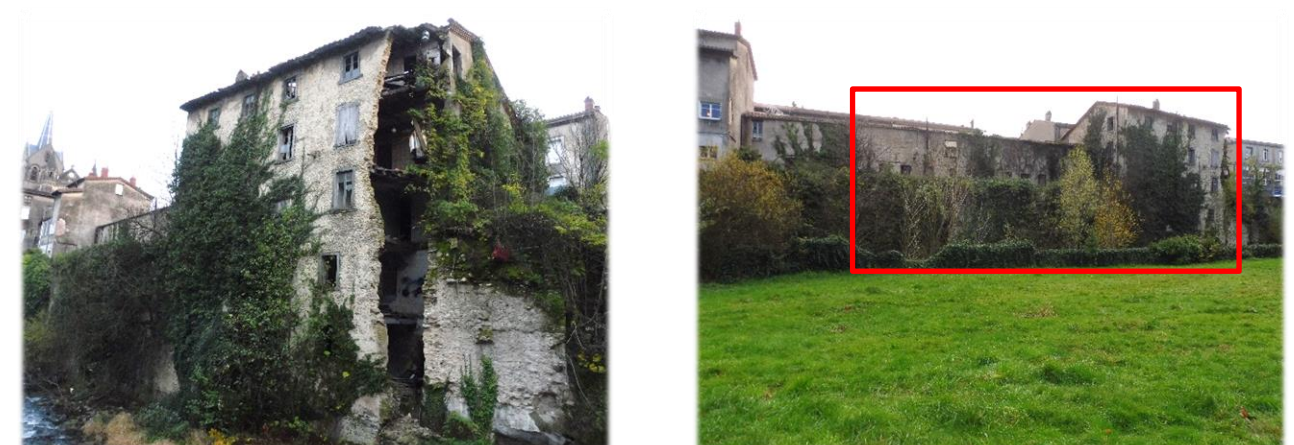
Vues du bâtiment à démolir – façade nord
