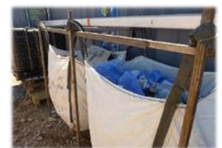
Dispositif de tri sélectif sur un chantier (Photo Naturalia)
