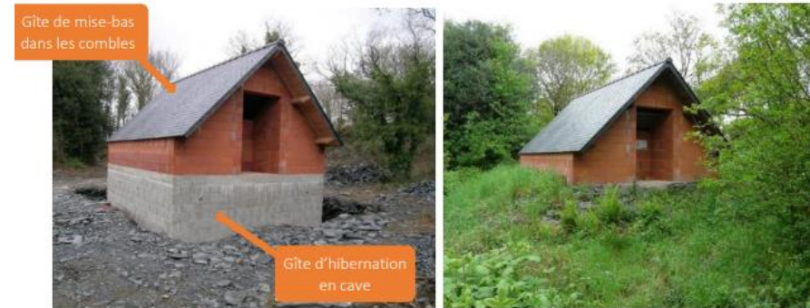
Exemples de construction de bâtiment de toutes pièces pour les chauves-souris (Vincent Wildlife Trust, à gauche et le Groupe Mammalogique Breton, à droite et en bas)
