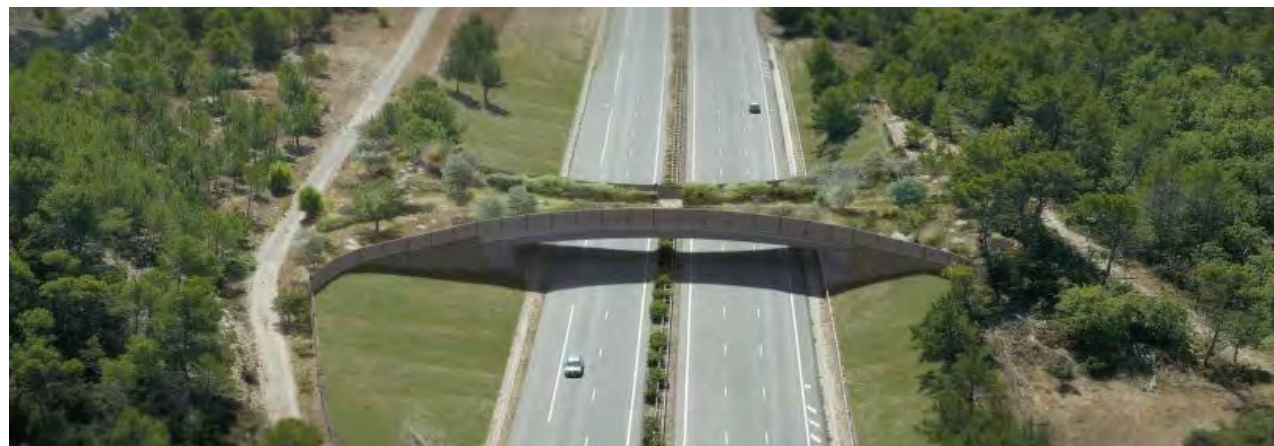
Figure 15 : Photomontage d'un ouvrage de type Diabolo, pour la transparence faunistique (Source : Egis, 2015)
