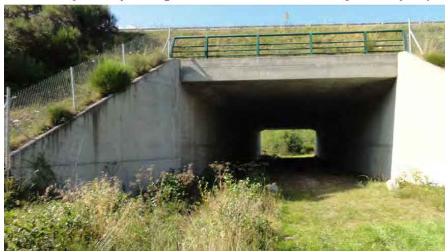
Illustration 3 : Exemple de passage mixte Grande faune / hydraulique (Source Egis)
