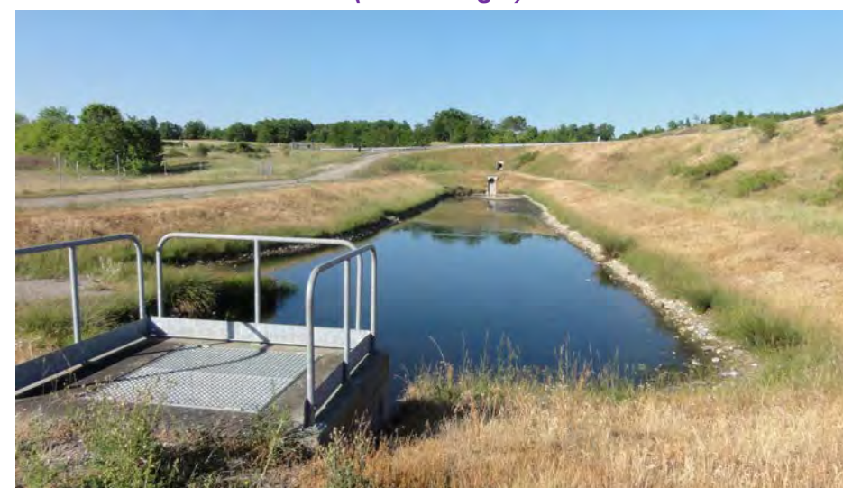
Illustration 5 : Exemple d'ouvrage de traitement des eaux avant rejet vers le milieu naturel (Source Egis)
