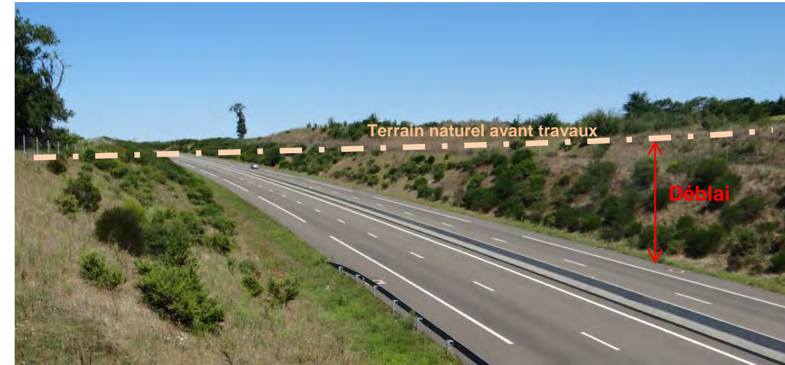
Illustration 6 : Cas d'un passage en déblai – au-dessous du niveau du terrain naturel (Source Egis)
