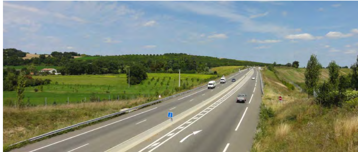
Illustration 1 : Fin de l'axe 2x2 voies de la RN126 sur Puylaurens (Source : Egis, 2014)
