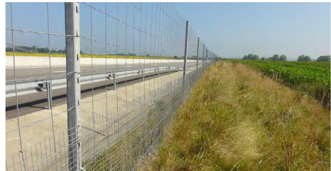
Figure 16 : clôture en bordure d'autoroute (Source : Egis)
