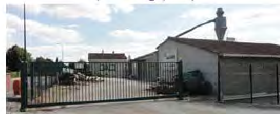
Illustration 35 : Entreprise Latger sur la commune de Cuq Toulza (Source : Egis, 2014)
