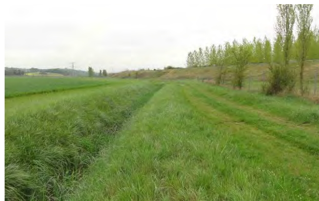
Cultures intensives et talus de remblais de l'A680 (Bonrepos-Riquet)
