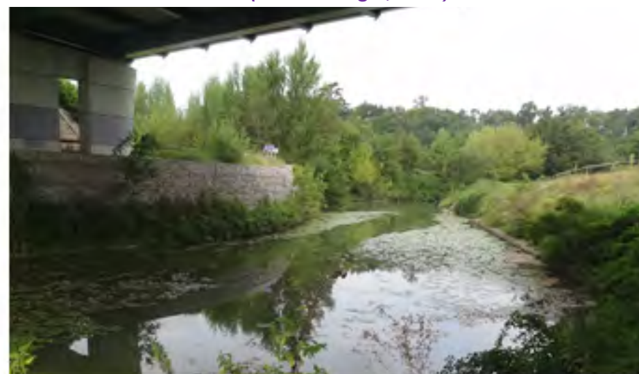
Illustration 177 : Le Sor sur la commune de Soual au droit du passage de la RN 126 (Source : Egis, 2014)
