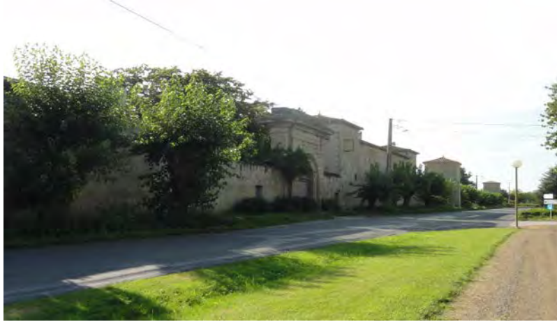
Illustration 104 : Chartreuse de Saïx sur la commune de Castres (Source : Egis, 2014)
