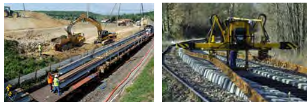
Illustration 17 : Travaux de terrassement et pose des rails (Source : Région Midi-Pyrénées)
