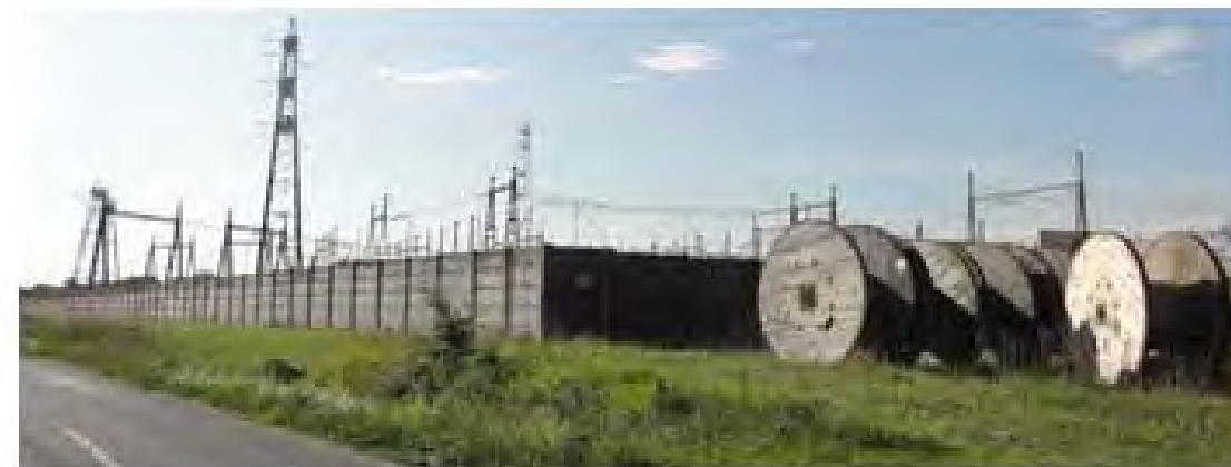
Illustration 34 : Poste électrique sur la commune de Verfeil (Source : Egis, 2014)
