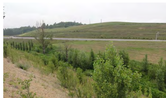
Vallon du Caudiès, au niveau de l'échangeur au sud de Puylaurens. Au second plan : la déviation.
