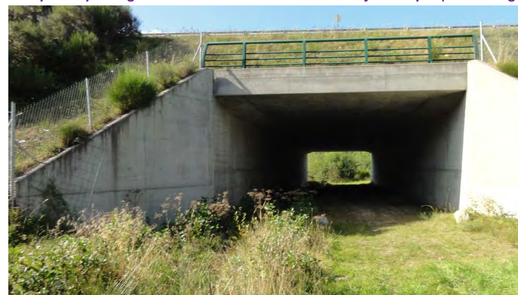
Exemple de passage inférieur mixte Grande faune / hydraulique (Source Egis)
