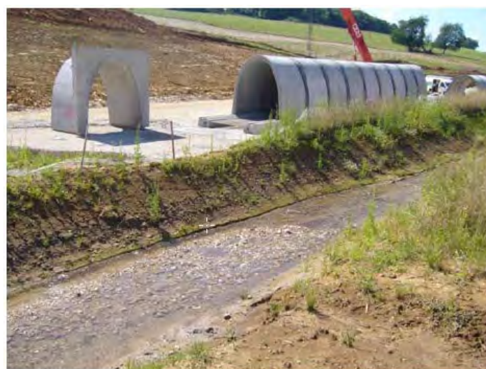
Déviations d'un cours d'eau pour la réalisation d'un ouvrage hydraulique à sec (A65, source : EGIS, 2010)
