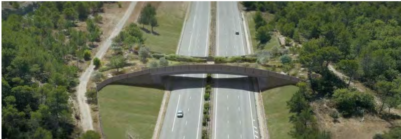
Figure 54 : Photomontage d'un ouvrage de type Diabolo, pour la transparence faunistique (Source : Egis, 2015)
