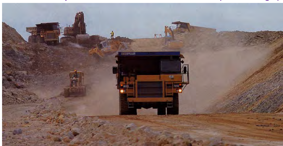
Emissions de poussières durant les terrassements (Source : Egis)
