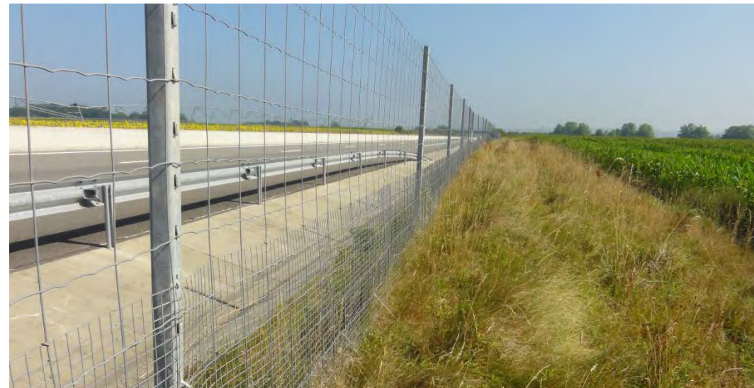
Clôture en bordure d'autoroute (Source : Egis)
