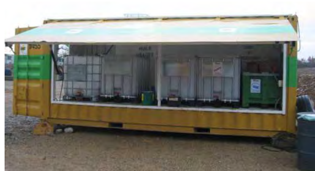
Stockage de produits polluants (Source : Egis)
