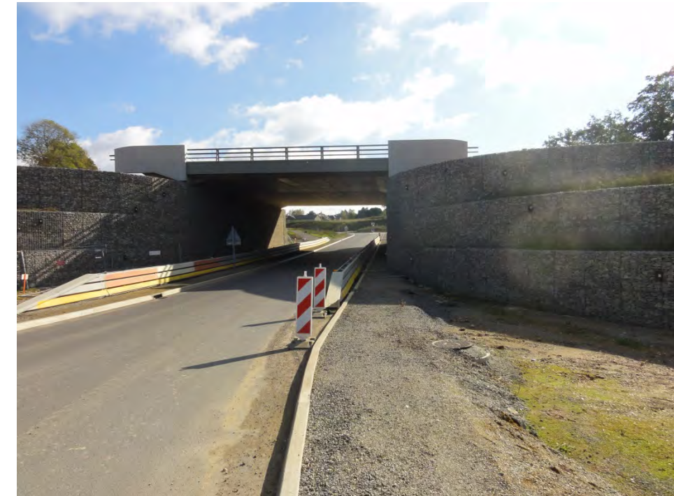
Rétablissement d'une voie existante en passage inférieur – PI (RN88, source : EGIS, 2013)
