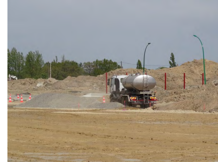
Arrosage des pistes de chantier en milieu urbanisé (A62, source : Egis, 2015)
