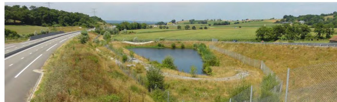
Bassin de rétention et de traitement des eaux pluviales (A65, source : EGIS)
