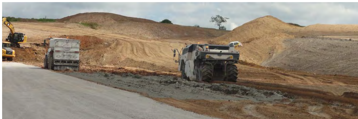
Opération d'épandage de liant hydraulique (source : EGIS)
