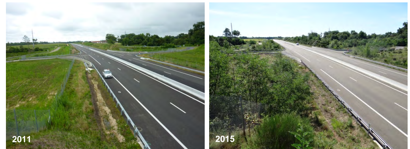
Insertion de l'infrastructure dans le paysage (A65, source EGIS, 2011, 2015)
