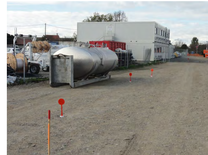
Base de chantier (A62, source : Egis, 2015)
