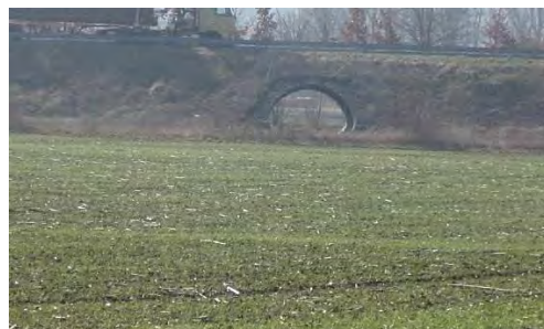
Ouvrage de décharge hydraulique de l'A680 (source : EGIS)
