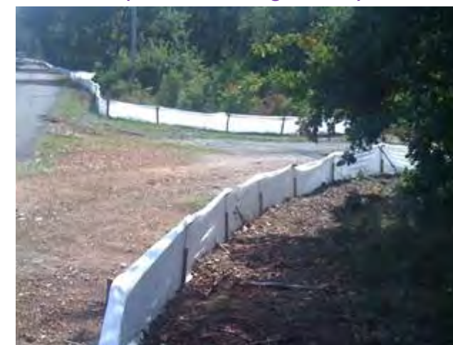
Pose de clôture provisoire pour amphibiens avec retour au droit d'accès riverains (A63, source Egis, 2011)
