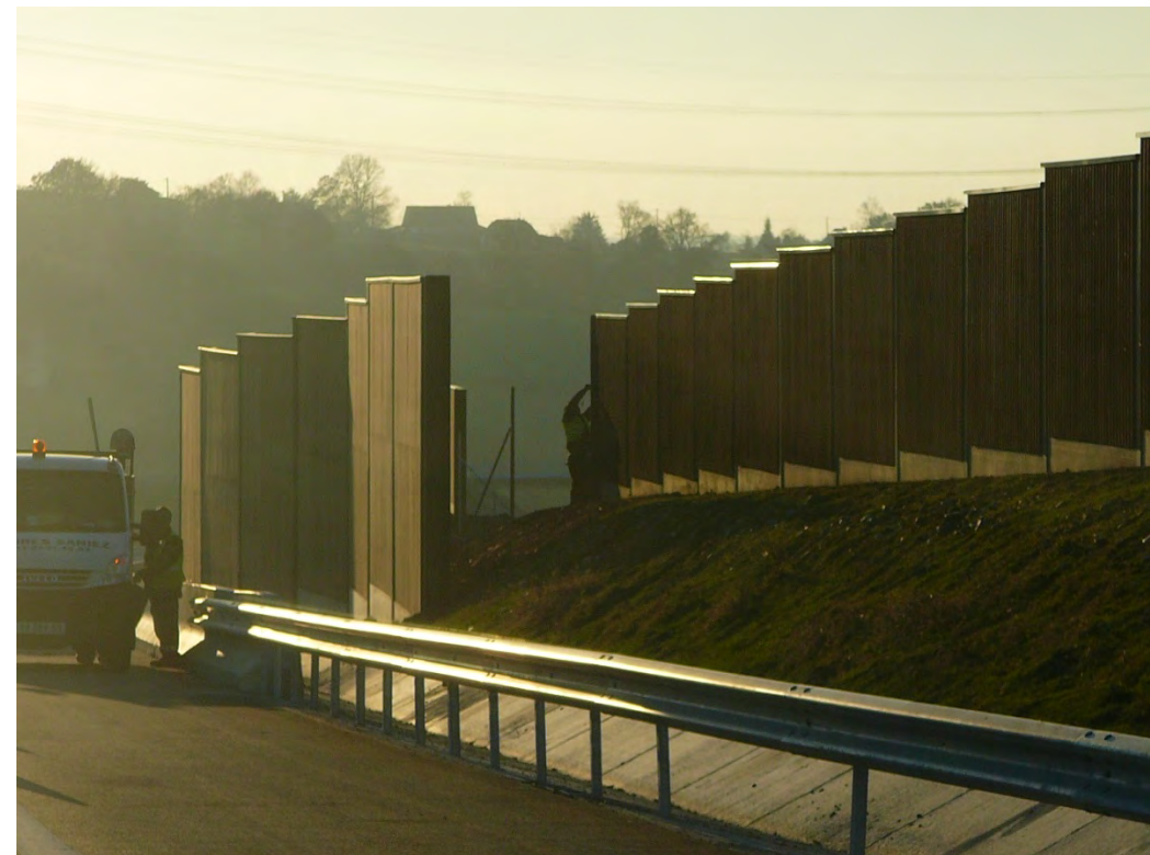
Mise en place de protections acoustiques (A65, source : EGIS, 2010)
