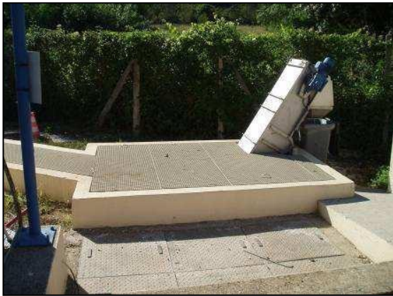
PR Bas avec dégrilleur
