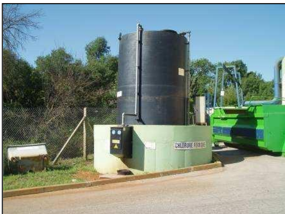
Cuve de Chlorure ferrique
