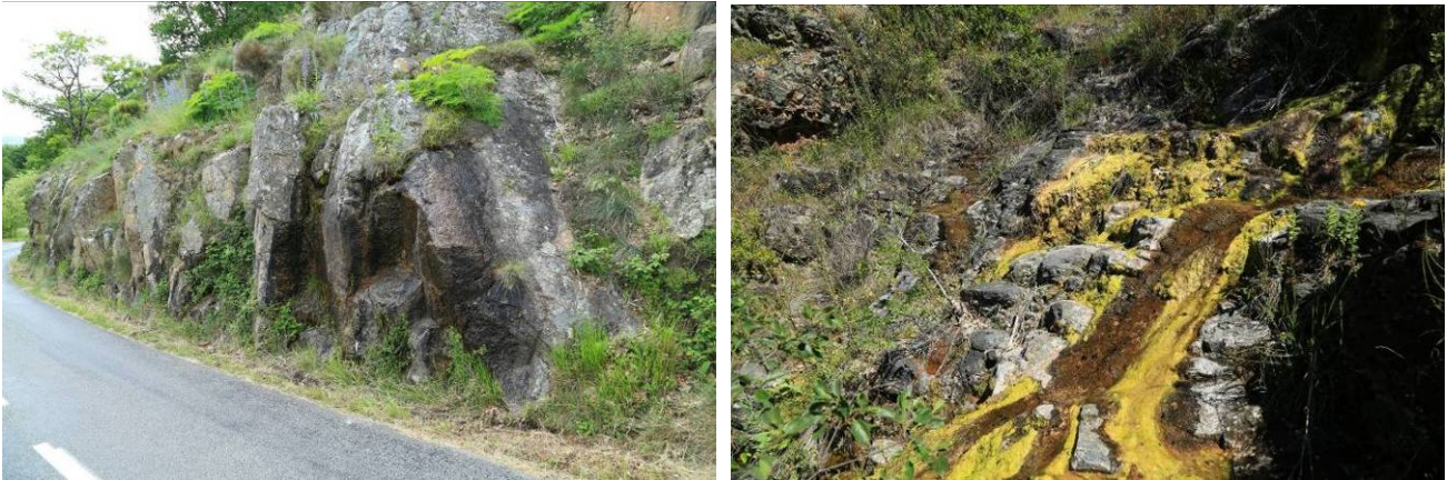
Suintements en bordure de route sur roche nue et au niveau de talweg rocheux
